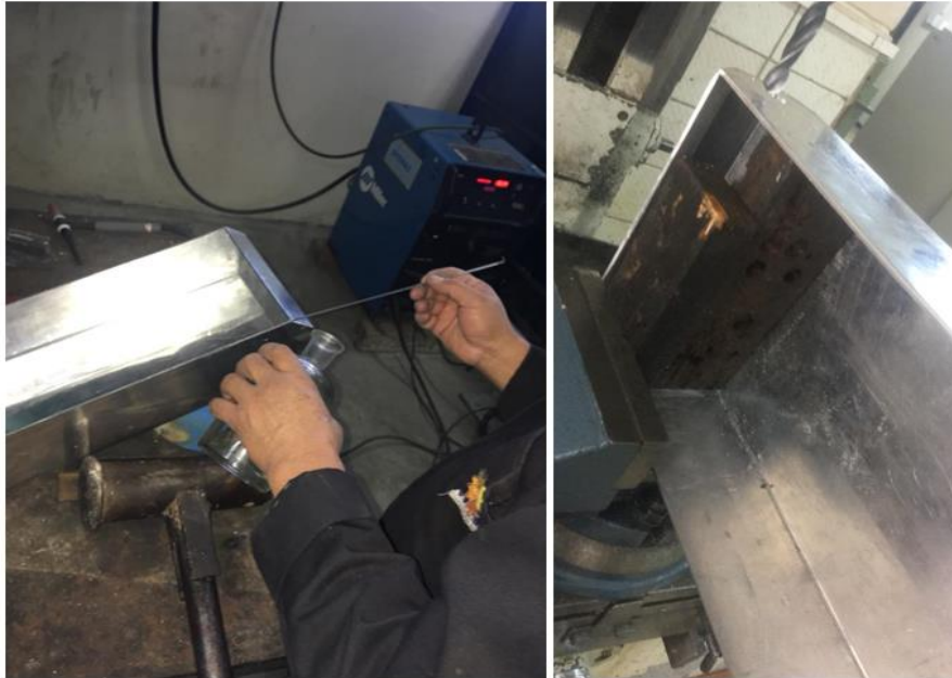
Figura 67. Proceso de soldadura y taladrado en el chasis y brazos
