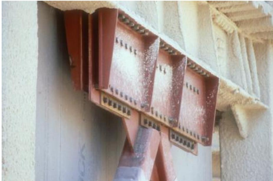
Figura 1.10. Amortiguador VE, Edificio 3M, Ciudad de México.
