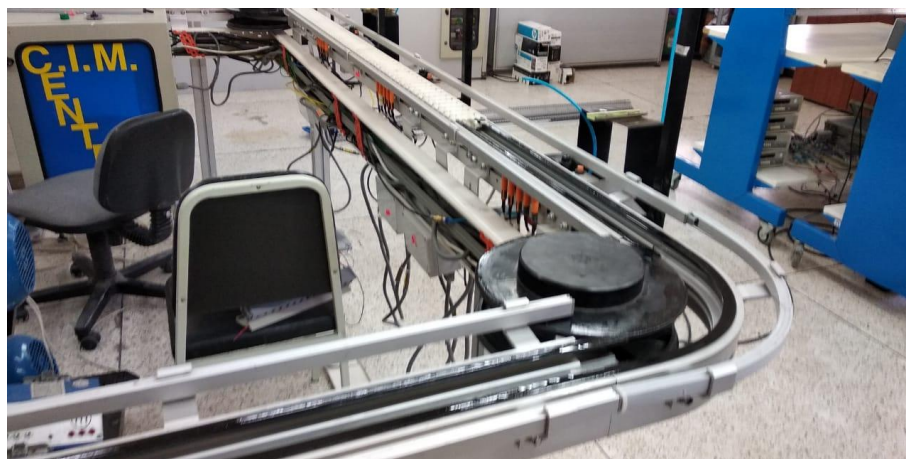
Figura 103. Mantenimiento de los rieles de la banda transportadora.
