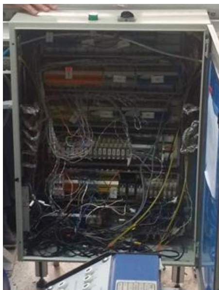
Figura 106. Tablero de control antes de ser reconectado.
