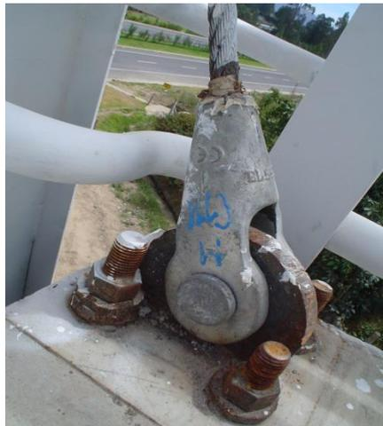
Fig. 7.12 Anclaje del cable al tablero
