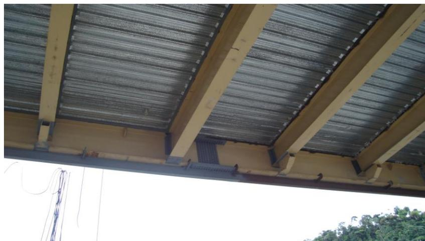
Imagen 3.1.14 Vigas del tablero y placa colaborante novalosa
