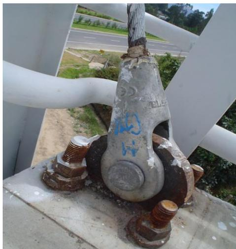
Fig. 6.13 Sistema de anclaje del cable al tablero para puentes de carga ligera.
