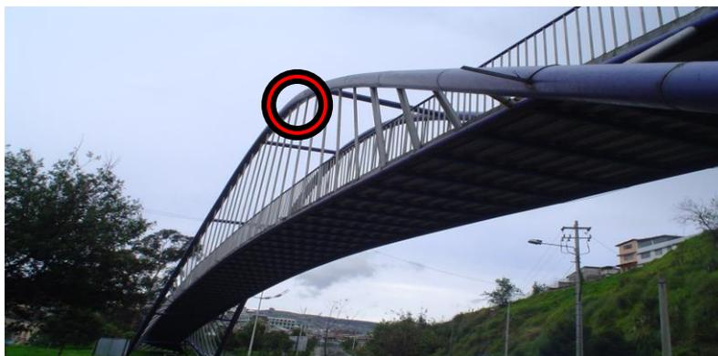
Imagen 3.2.16: Estructuras de apoyo del tablero
