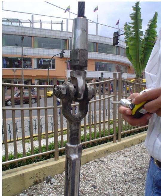
Imagen 3.2.13: Unión tensor al tirante a ser tensado
