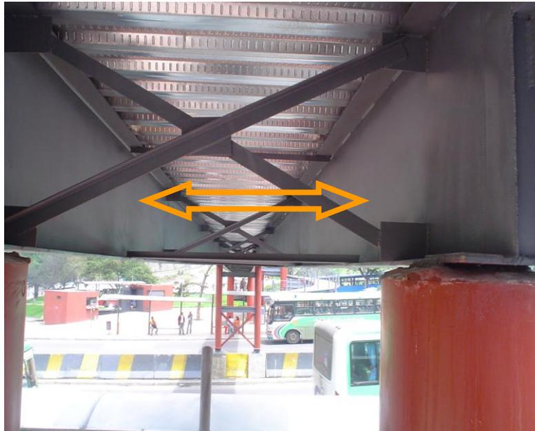
En la siguiente imagen se muestra como debería ser un sistema de arriostramiento en el alma de vigas tipo I conocidos como corta – pandeos.
