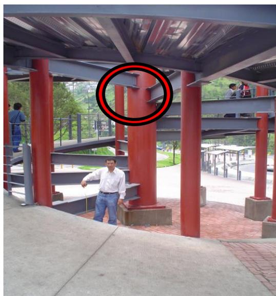
2. El segundo problema que se encontró fue en las vigas Tipo I de la estructura que conforma el tablero, estas I tienen un alma de 90cm de altura con un espesor apenas de 6mm, es por eso que se sugiere que tengan un sistema de rigidizadores en el alma de la viga a parte de sus atiesadores que se encuentran en cruz. Esto es necesario para que no exista pandeo en el alma de las vigas.
