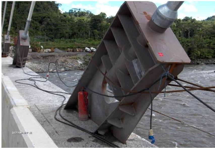
Imagen 3.1.10 Porta obenques de estructura metálica
