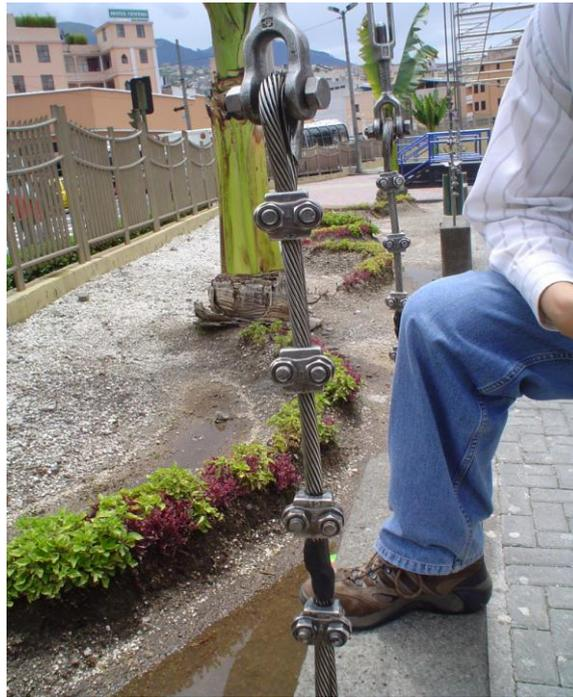
Imagen 3.2.12: Cable anclado al muerto de hormigón
