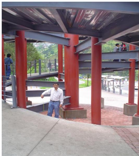
Imagen 3.2.3 : Pilas que sostienen la calzada
