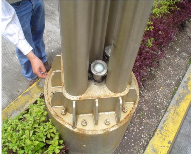
Imagen 3.2.9: Base de la columna donde se anclarán los cables
