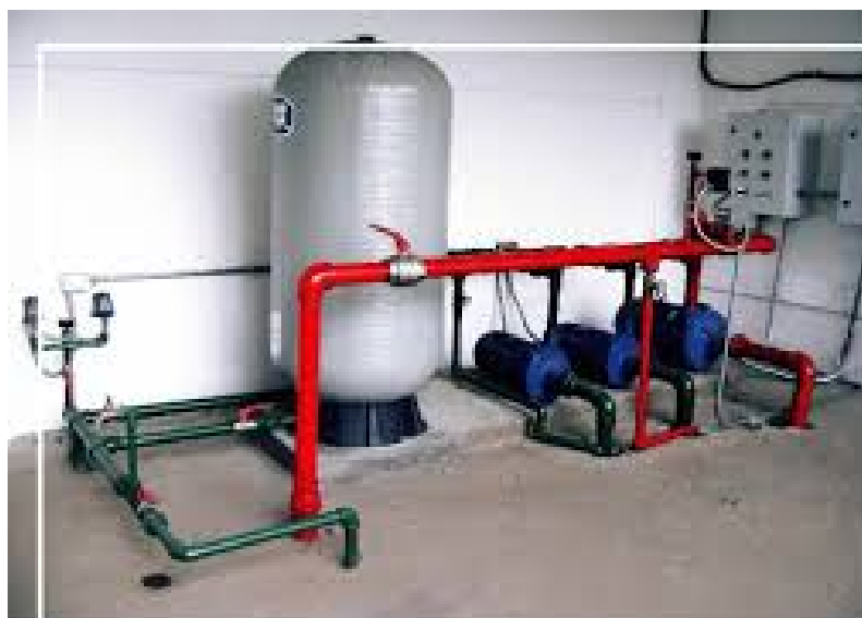
Figura 23. Sistema Hidroneumático.
