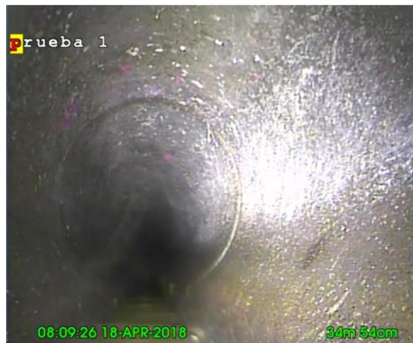
**Figura 46.** Existencia de gases acumulados en el colector
