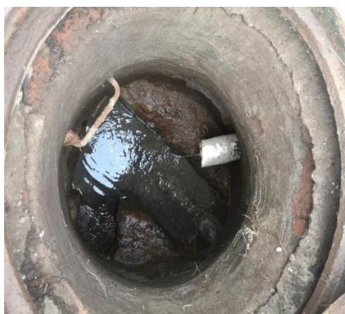
**Figura 37. Acometida domiciliaria tubería no revocada**
