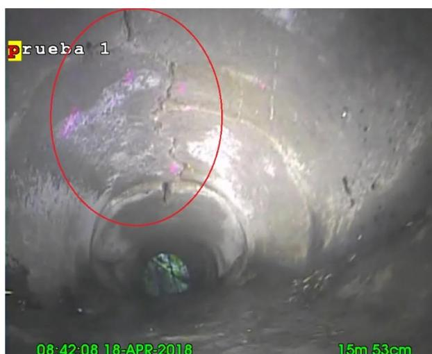
**Figura 48.** Tubería fisurada parte superior
