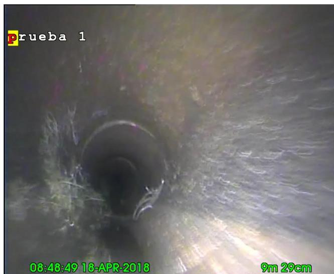
**Figura 47.** Tubería obstruida con sedimento.
