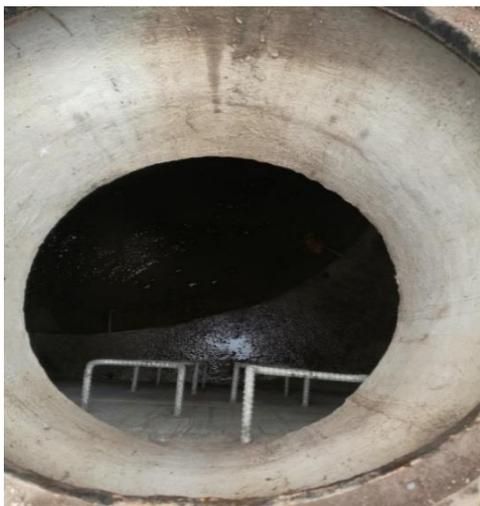
**Figura 39.** Pozo revisión del alcantarillado pluvial
