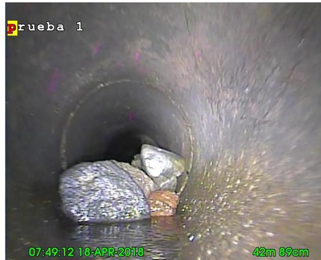
*Figura 42.* Presencia de material pétreo en la tubería.
