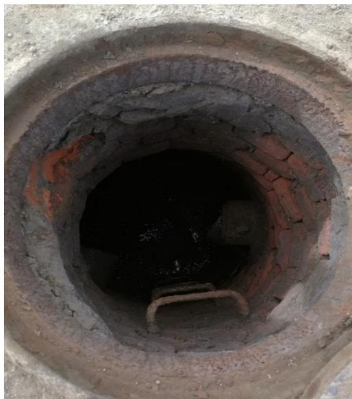
**Figura 36.** Pozo de revisión sin recubrimiento de mortero.
