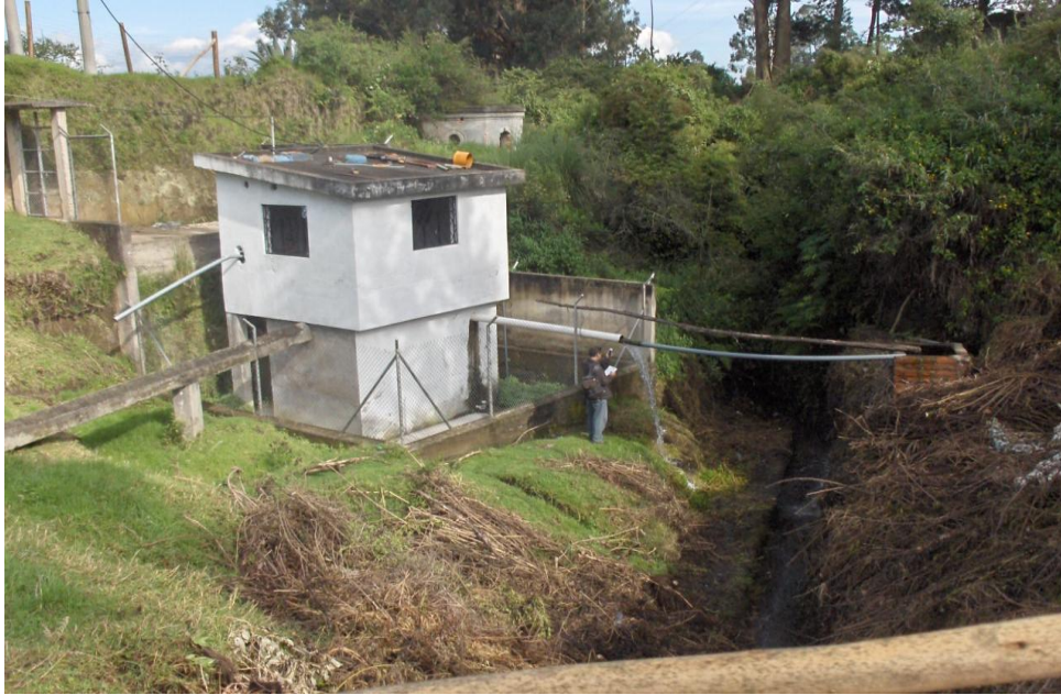
Captación en Vertiente, Fotografía 2
