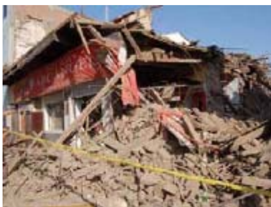
Figura 1. 7 Vivienda de adobe destruida por el terremoto de Perú 5 .
