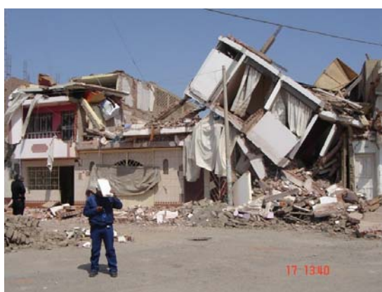
Figura 1. 8 Daños estructurales en vivienda de albañilería en Ica 6 .
