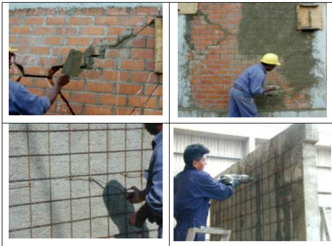
Figura 5.3 Proceso de reforzamiento de mampostería con malla electrosoldada 40
