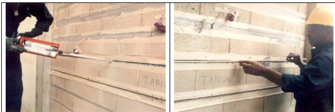
Figura 5.9 Proceso de reforzamiento de mampostería con varillas de fibra de vidrio 46
