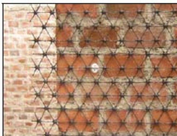
Figura 5.15 Detalle de la aplicación de las mallas de polímero en la mampostería 50
