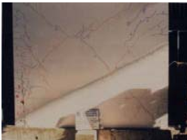
Figura 5.4 Muro reforzado con malla electrosoldada luego del ensayo de carga lateral cíclica 41
