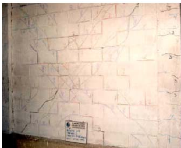
Figura 5.11 Fisuración del espécimen IM2 luego del ensayo de carga lateral cíclica coplanar 47
