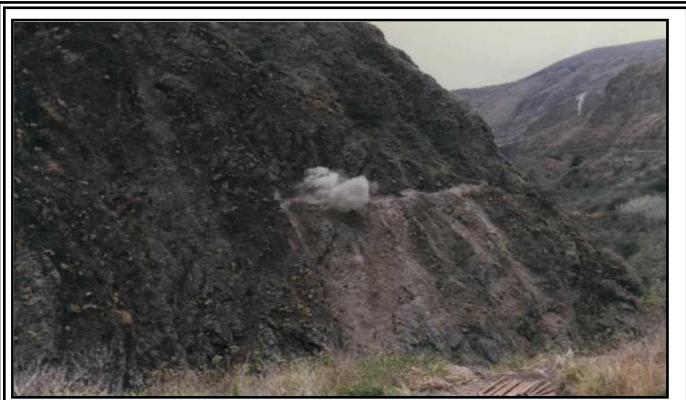
FOT. 06 VISTA GENERAL DE LAS LADERAS Y PENDIENTES EN EL SITIO DEL PROYECTO
