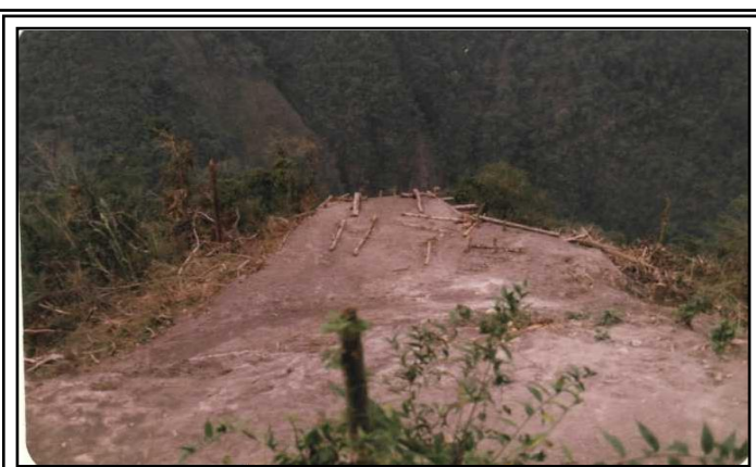
FOT. 38 SITIO DEL CAMPAMENTO DEL PROYECTO HIDROELÉCTRICO "CHESPI"
