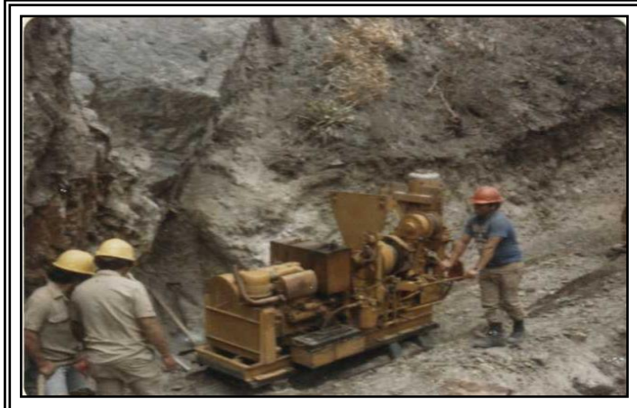
FOT. 23 MOVILIZACIÓN DEL EQUIPO DE PRUEBA, DESDE EL CAMPAMENTO AL SITIO DE LA PRESA
