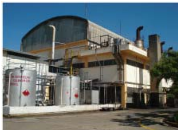
Figura. 2. 2. Foto de la Central Termoeléctrica Guangopolo.
