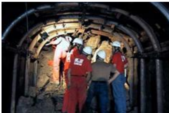
Fotografía No.6: Minería Aurelian Ecuador S.A.
