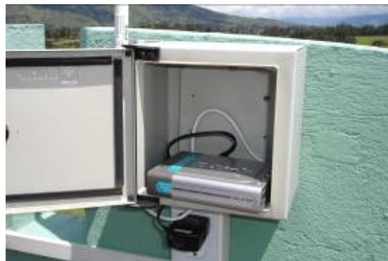
Figura. 7.25. Cajas para intemperie con su respectivo AP
