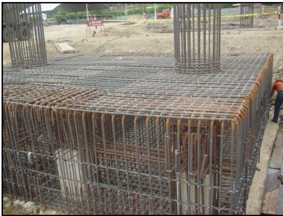
Figura 1. 8: Armado de las zapatas del Acceso de Bahía
