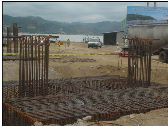
Figura 1. 8: Armado de las zapatas del Acceso de Bahía
