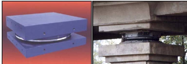
Figura 1. 19: Aisladores de Base (FPS) (Romo 2009, CEE 2008)
