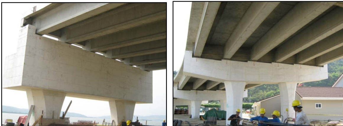
Figura 1. 10: Pilas del Acceso de Bahía
