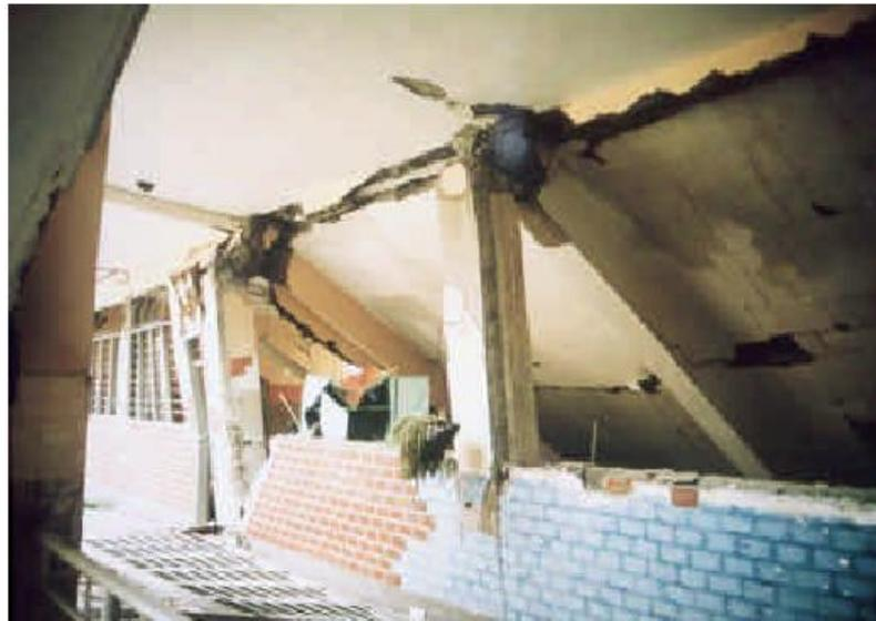
**Figura 4.4** Falla en la unión viga columna por falta de estribos
