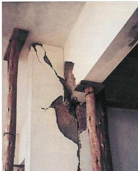
**Figura 3.1** Nudo sin estribos y falla por tracción diagonal
