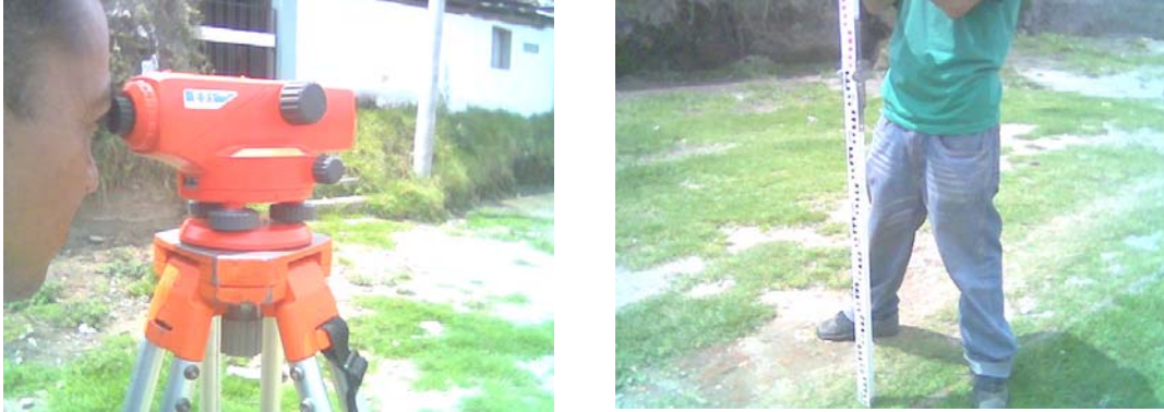
Foto 3.3. Equipo: Nivel SOKKIA y regla durante la nivelación.
