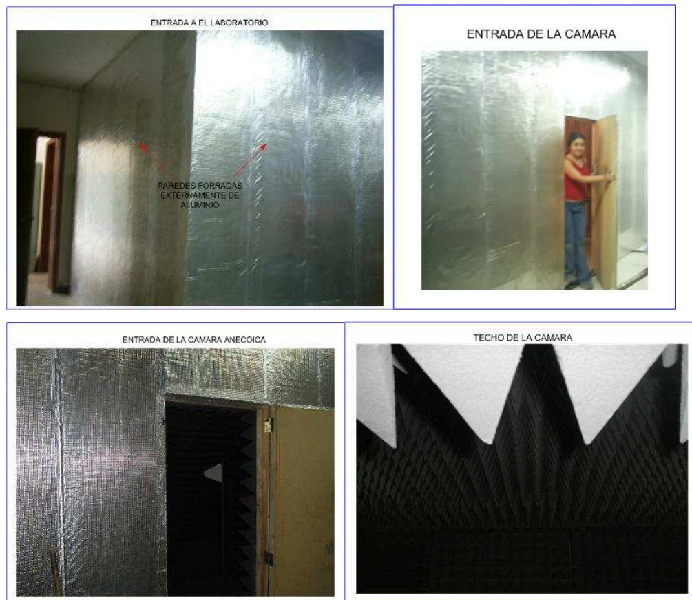
Figura. IV.37. Etapa final del proceso de construcción
