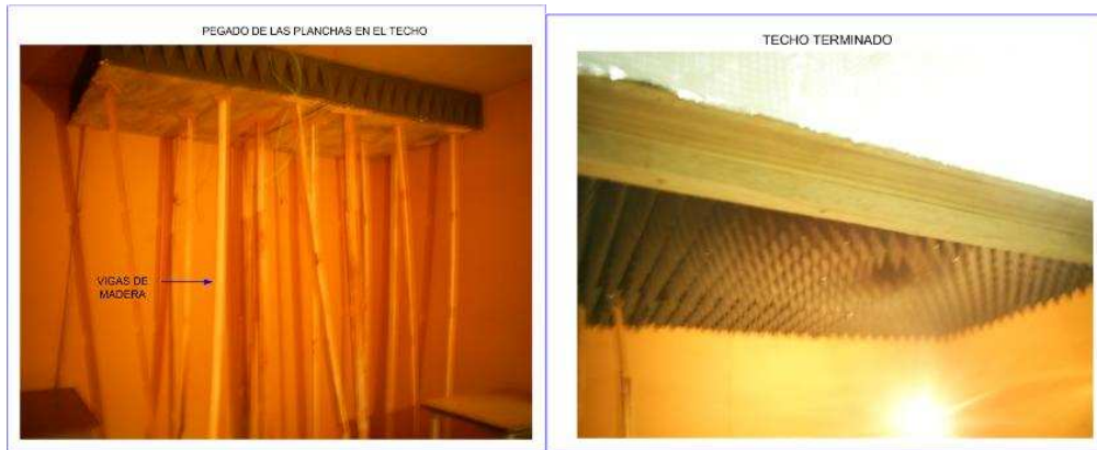
Figura. IV.31. Colocación del material absorbente en el techo de la Cámara
