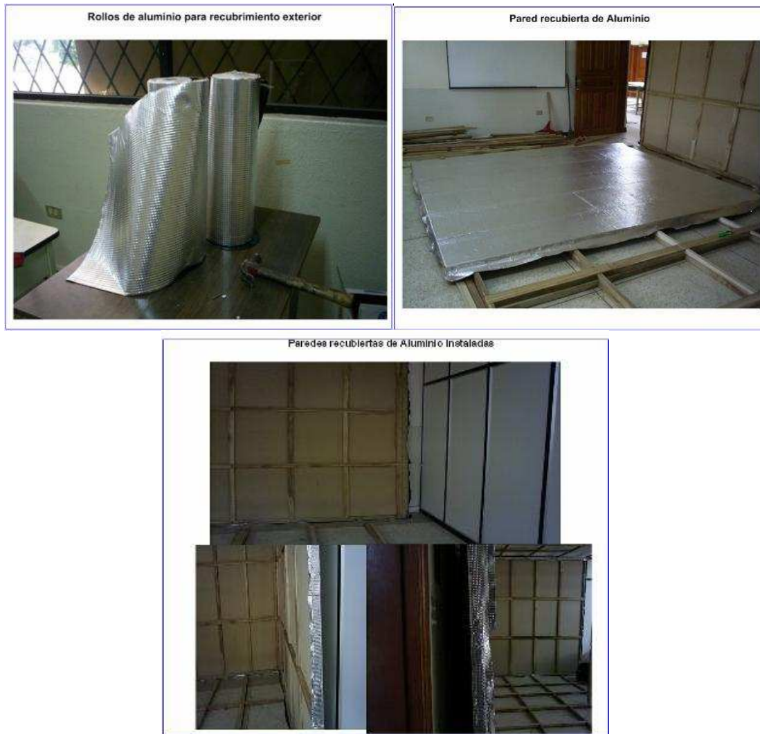
Figura. IV.24. Bandas de Aluminio para recubrir la parte externa de las paredes
