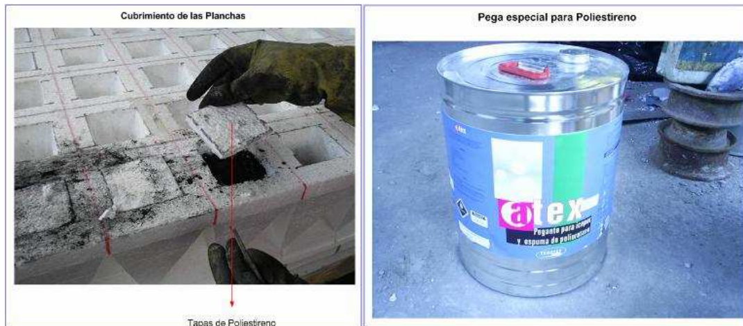
Figura. IV.21. Cubrimiento de las planchas y goma utilizada
