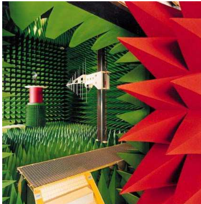
Figura II.32. Interior de una Cámara Anecoica
