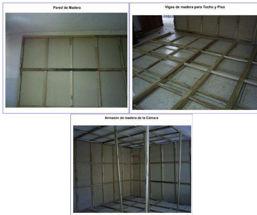
Figura. IV.23. Estructura de madera de la Cámara
