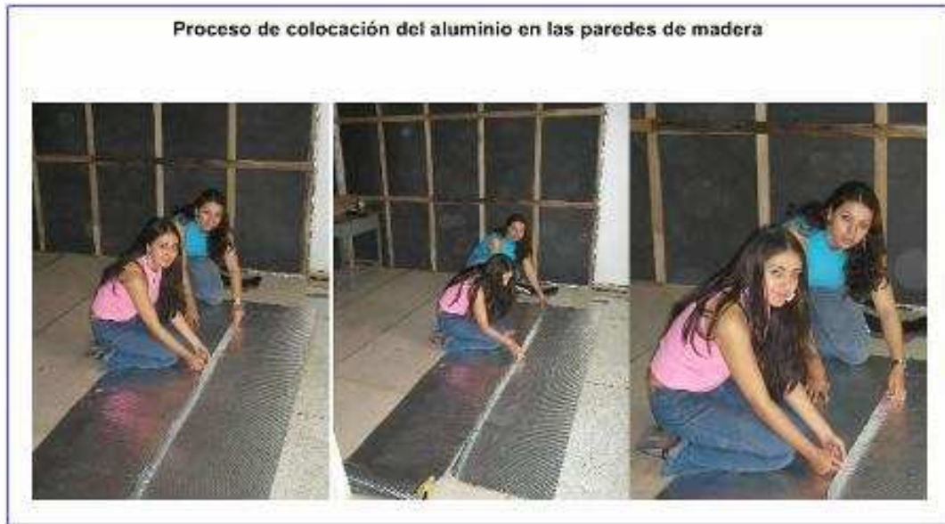
Figura. IV.25. Colocación de las bandas de aluminio
