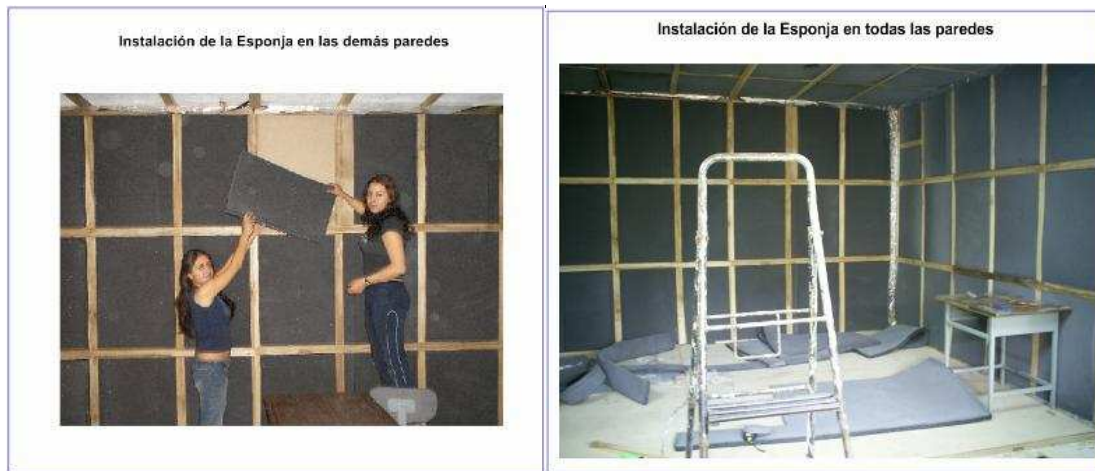
Figura. IV.27. Colocación de las planchas de polietileno
