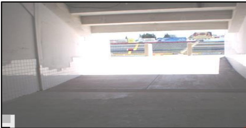
Figura 36. Salida No.7 tipo Rampa Fuente: (Garcés, 2018)
