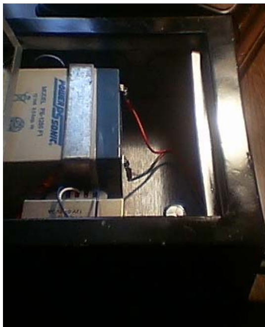
Figura. 4.1. Suministro de Energía
