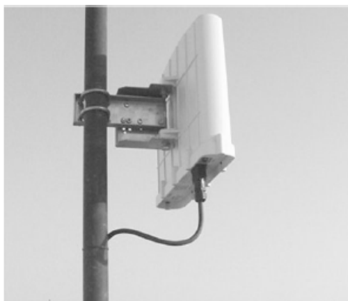
Figura. 2.109. Instalación típica de una BSR
