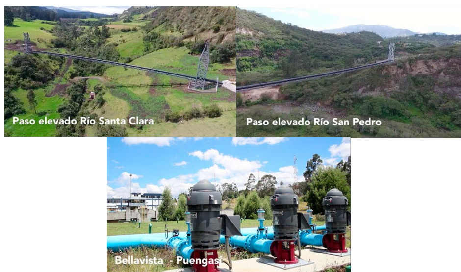
Figura 24. Obras de mitigación, pasos elevados y bombas
