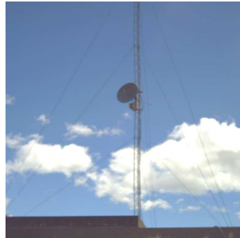
Figura. 5.28. Torre San Rafael
