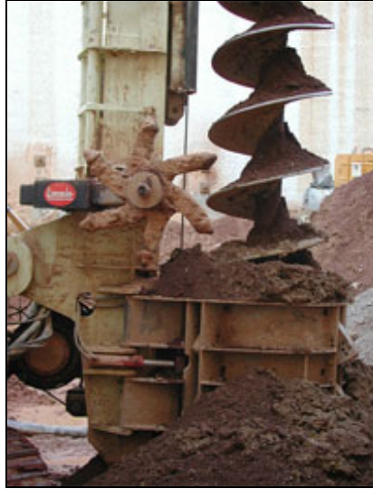
Figura 2.1: Extracción de tierra para colocar luego la armadura. (32)
