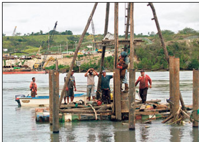
Figura 1.1: Perforaciones realizadas en el Río Esmeraldas sobre balsas y con la ayuda de grúas. (31)
