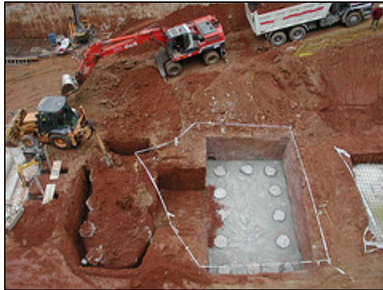
Figura 2.7: Excavaciones para el hormigonado de pilotes. (29)
