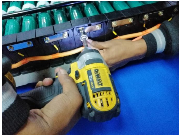
Figura 22. Placas de la batería de celdas cilíndricas para establecer las conexiones entre módulos
