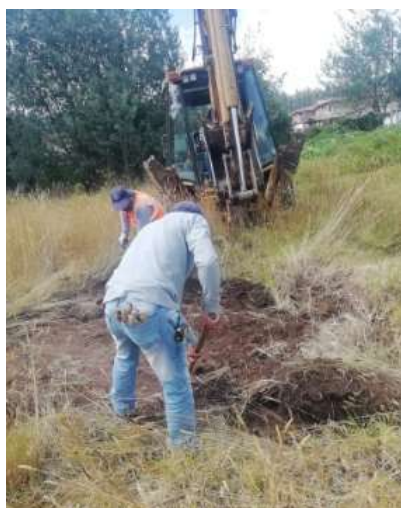
Figura 15. Excavación de calicata
