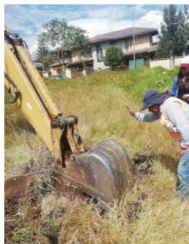
Figura 14. Excavación con máquina
