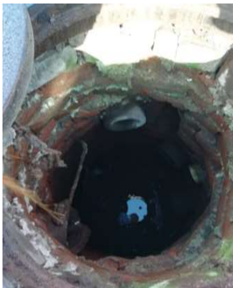
Figura 27. Interiores del Pozo N° 2, sin revestimiento
