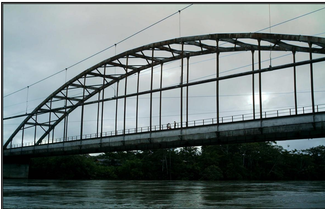
Foto 2.1. Estación en el puente de San Sebastián sobre el río Coca
