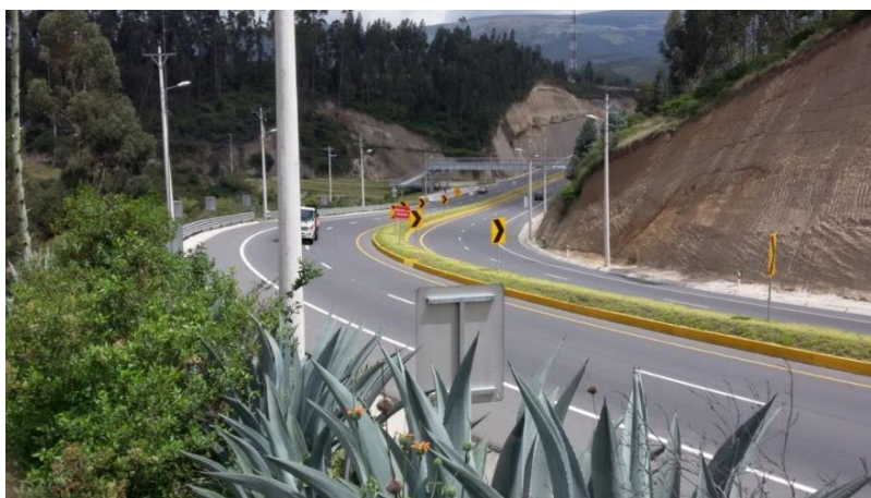
Figura 6. Puente Peatonal Entrada Itulcachi - Vía E35
