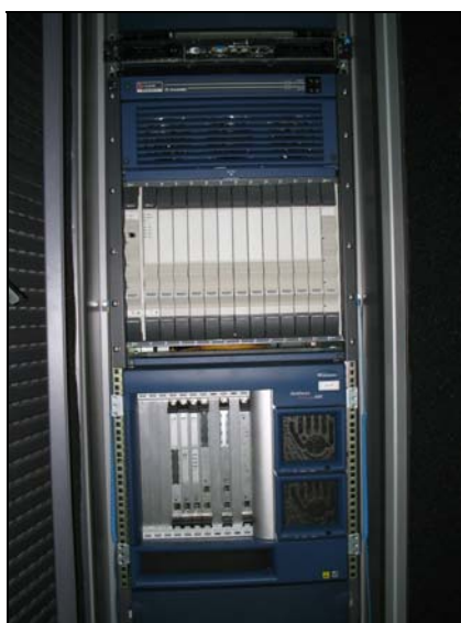
Fig. 2.3-19 fotografía del Gateway de Medios Universal UMG8900 (parte superior)
