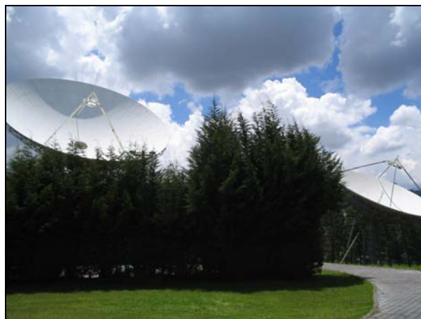
Fig. 2.3-16 Fotografía de la Estación Terrena de ANDINATEL S.A.
