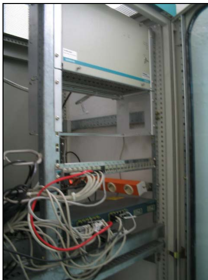
Fig. 2.4-27 Fotografía del Multiplexor del COMAG SIEMENS
