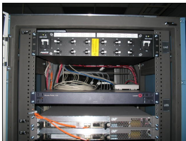
Fig. 2.3-12 Fotografía del LAN Switch y Access Point del FE de la Central TDQ2
