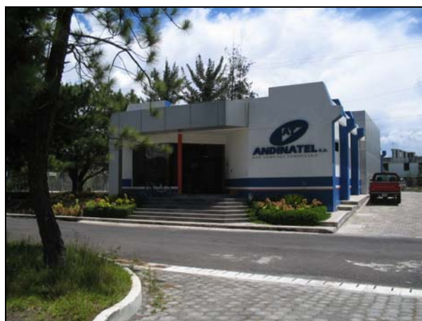
Fig. 2.4-31 Fotografía del COMAG HUAWEI (Estación Terrena)
