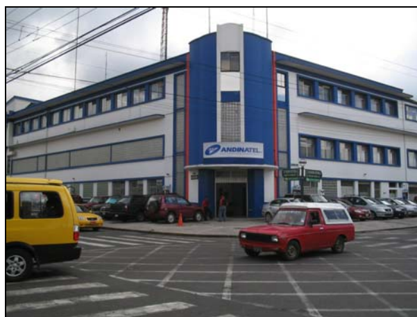
Fig. 2.4-26 Fotografía del edificio Mariscal Sucre de ANDINATEL S.A.
