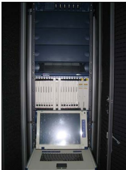
Fig. 2.3-18 Fotografía de las Tarjetas CSU del SoftX3000
