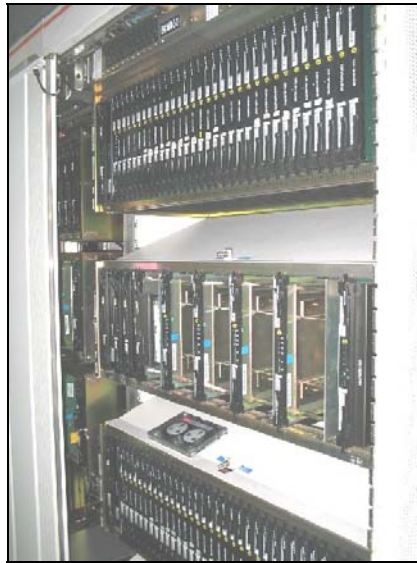
Fig. 2.3-4 Fotografía del Punto de Control del Servicio (SCP)
