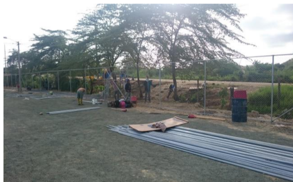
Figura 55. Malla galvanizada empleada en los cerramientos perimetrales.
