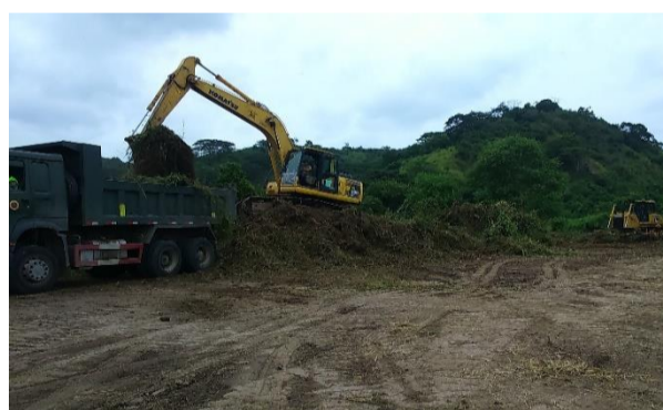
Figura 27. Transporte del material de desbroce
