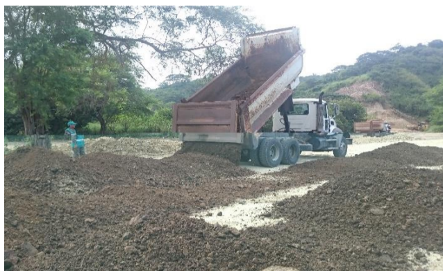
Figura 36. Colocación de material de subbase sobre la subrasante.
