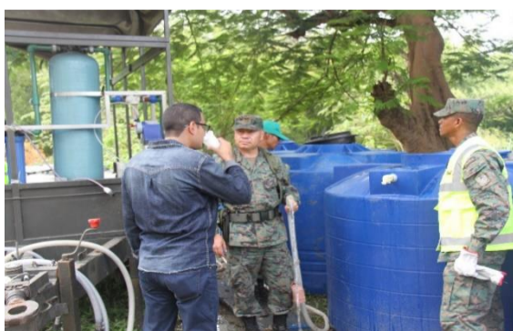
Figura 67. Tanques de abastecimiento
