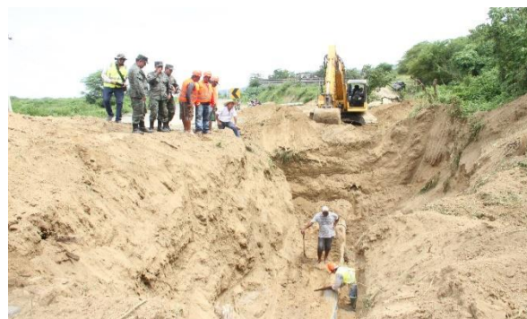
Figura 43. Reparación de la red de agua potable por parte del CEE.
