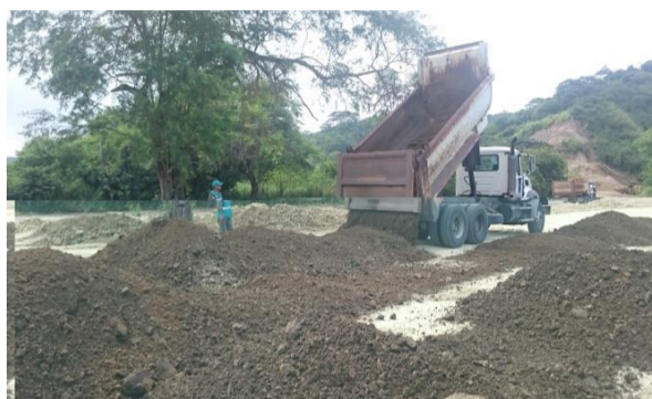
Figura 33. Colocación del material granular en el albergue de Canoa.
