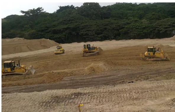
Figura 30. Movimientos de tierra realizados en el albergue de San José de Chamanga.
