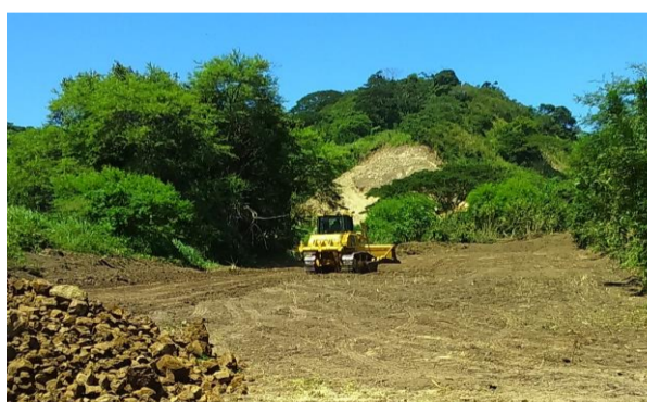
Figura 26. Desbroce y descapote
