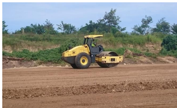
Figura 39. Compactación del material granular con el rodillo liso.
