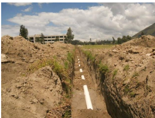
Figura 52. Rellenos que se ejecutan en tuberías del sistema de alcantarillado
