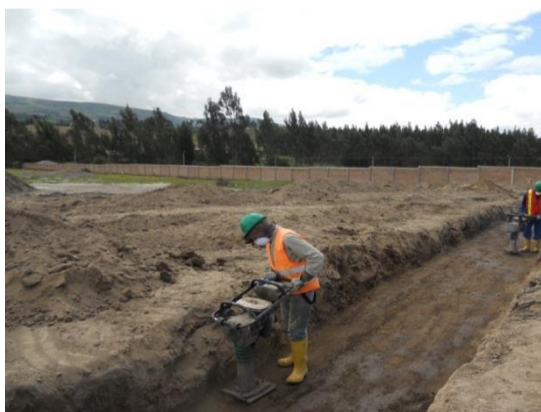
Figura 53. Compactación ejecutada con rodillos neumáticos.
