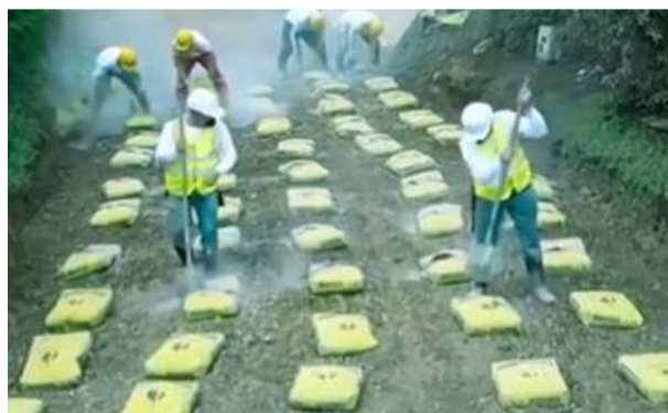
Figura 35. Estabilizadores químicos para mejorar la capacidad portante del suelo.
