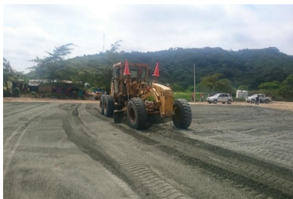
Figura 37. Mezcla, homogenización y esparcimiento de material de base.
