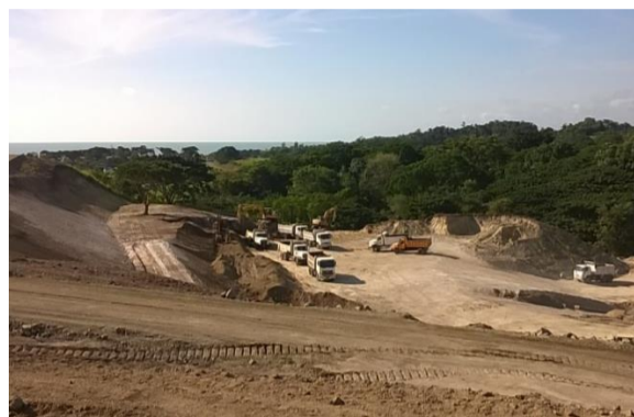
Figura 31. Maquinaria empleada en el desalojo de material excedente.
