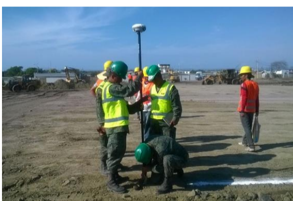
Figura 28. Equipo de topografía empleado en el replanteamiento de albergues
