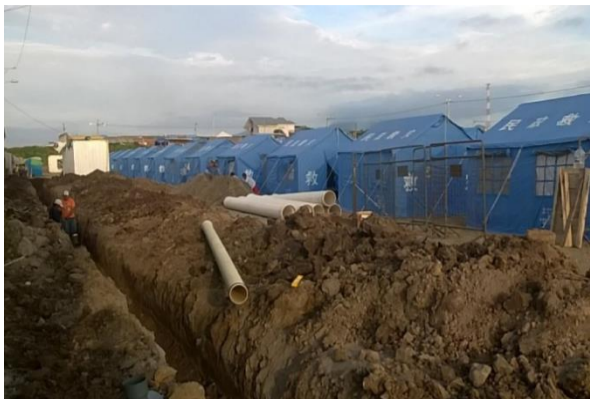
Figura 40. Excavación realizada para la colocación de la red de alcantarillado.
