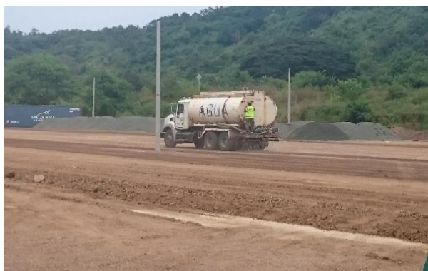
Figura 38. Riego de agua a través de tanquero para obtener la humedad adecuada.
