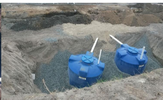
Figura 70. Tanques soterrados
