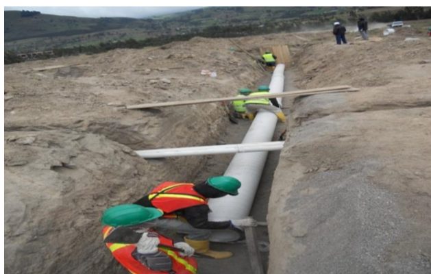
Figura 46. Tuberías de PVC colocadas en los sistemas de alcantarillado
