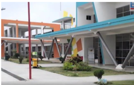
Figura 12. La Unidad educativa del Milenio de Pedernales antes del sismo.
