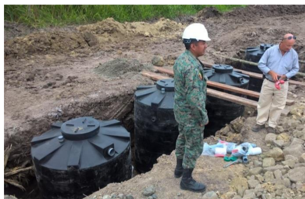
Figura 47. Tanques sépticos empleados en los albergues temporales.
