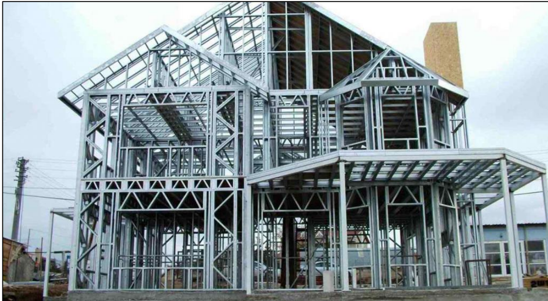
Figura 3. Vivienda de dos pisos construida en el sistema steel framing
