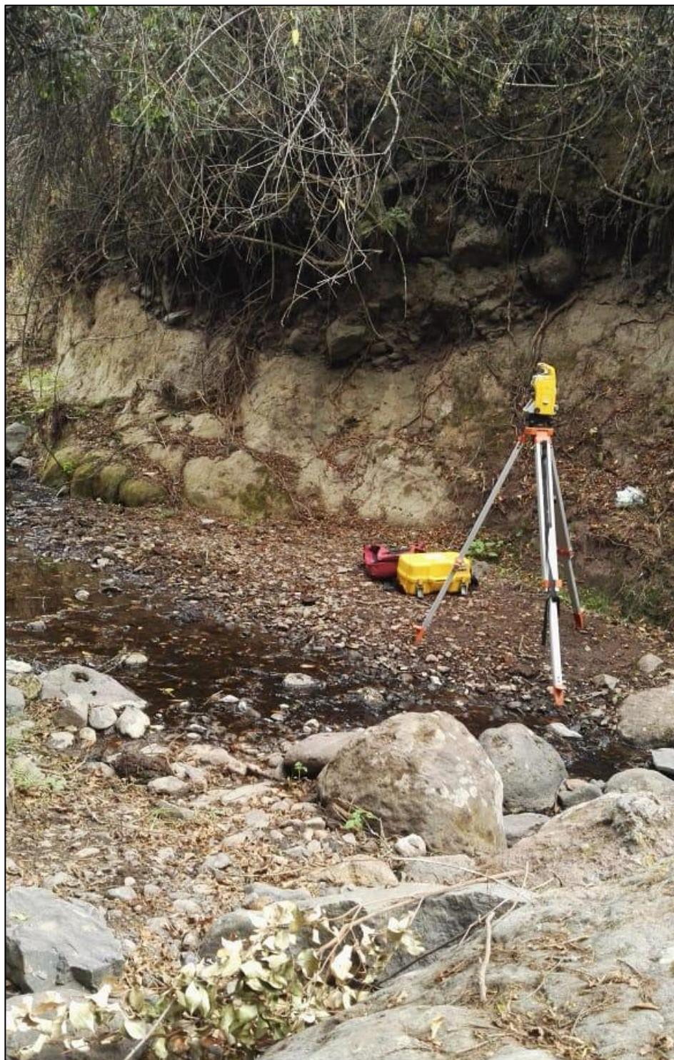
**Figura 9.** Levantamiento Topográfico con Estación Total en la sección del río
