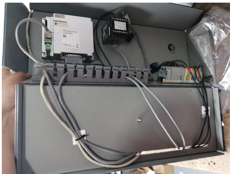
Figura 23. Cableado para la conexión de todos los dispositivos.
