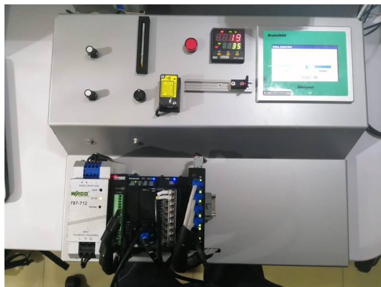
Figura 24. Posicionamiento de los dispositivos en la parte baja del módulo.
