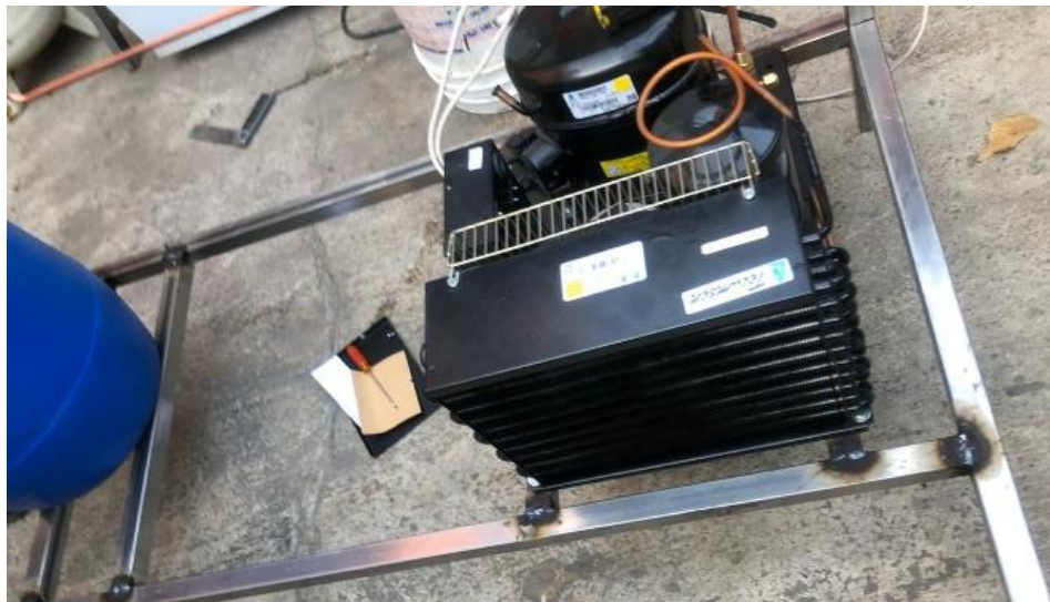
Figura 42. Unidad condensadora Tecumseh 1 [HP]
