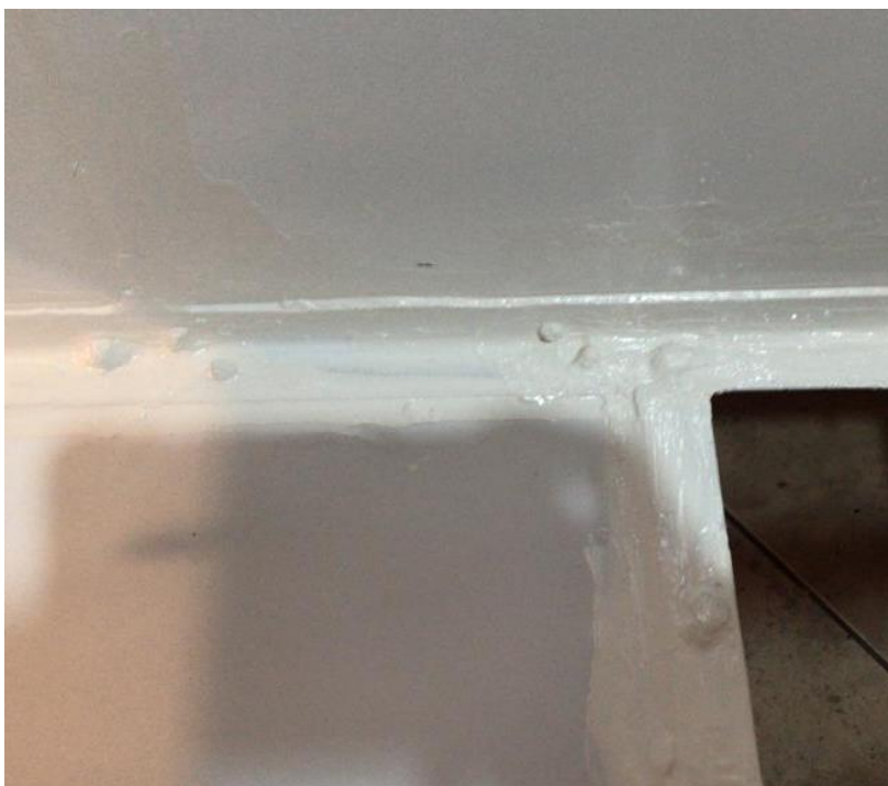
Figura 58. Sellado con resina aislante
