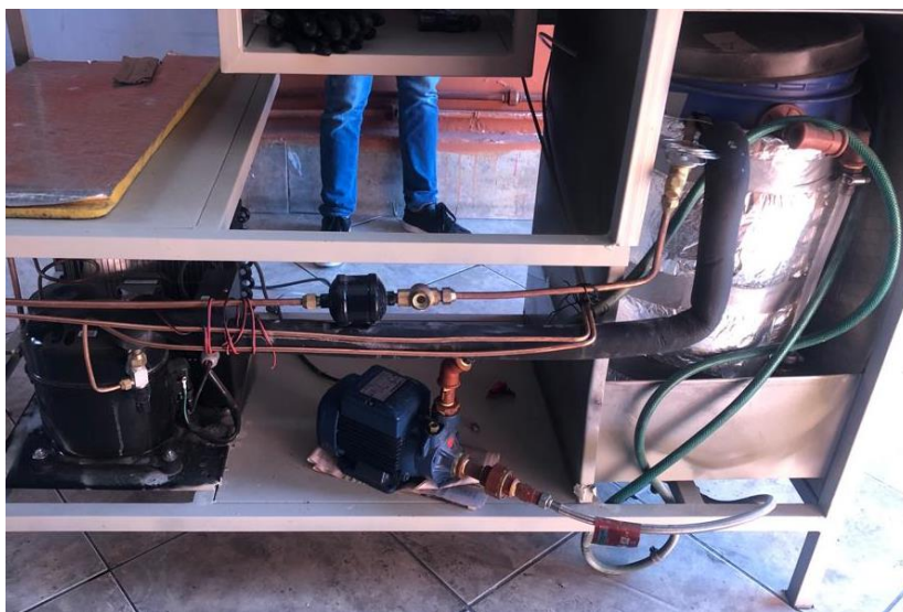
Figura 47. Instalación de la bomba de 0.5 [HP]
