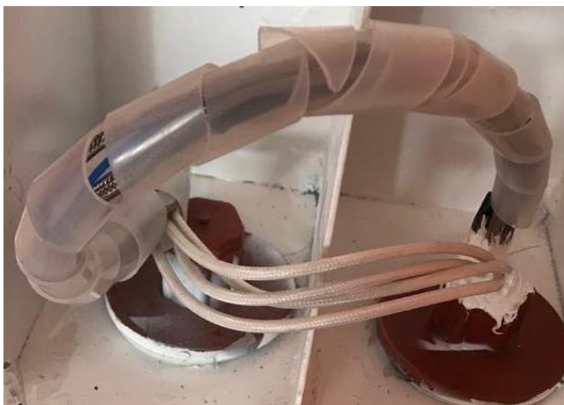
Figura 59. Aislamiento con resina adhesiva
