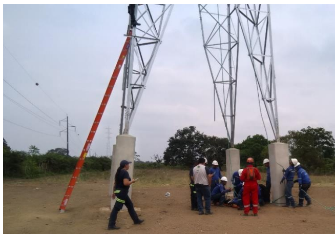
Figura 10. Entrenamiento sobre rescate en alturas - en la línea 230 KV Milagro - Babahoyo
