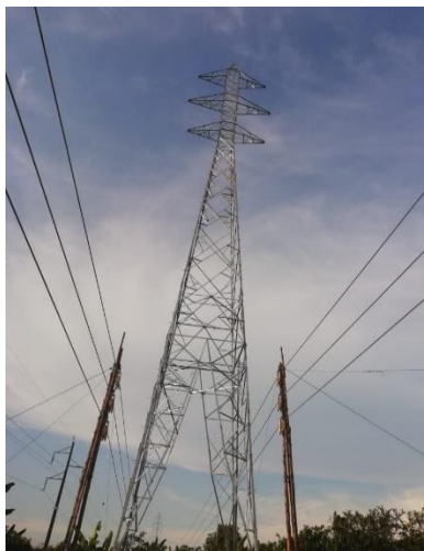
Figura 9. Tendido de conductores con pórticos provinciales -línea 230 KV Milagro – Babahoyo
