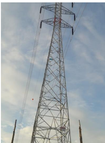
Figura 11. Pintura y señalización de estructuras - en la línea 230 KV Milagro – Babahoyo
