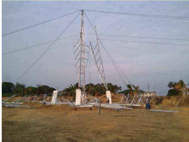
Figura 4. Montaje de Torres SL línea 230 Milagro - Babahoyo
