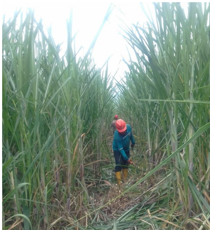
Figura 8. Desbroce en la línea 230 KV Milagro - Babahoyo
