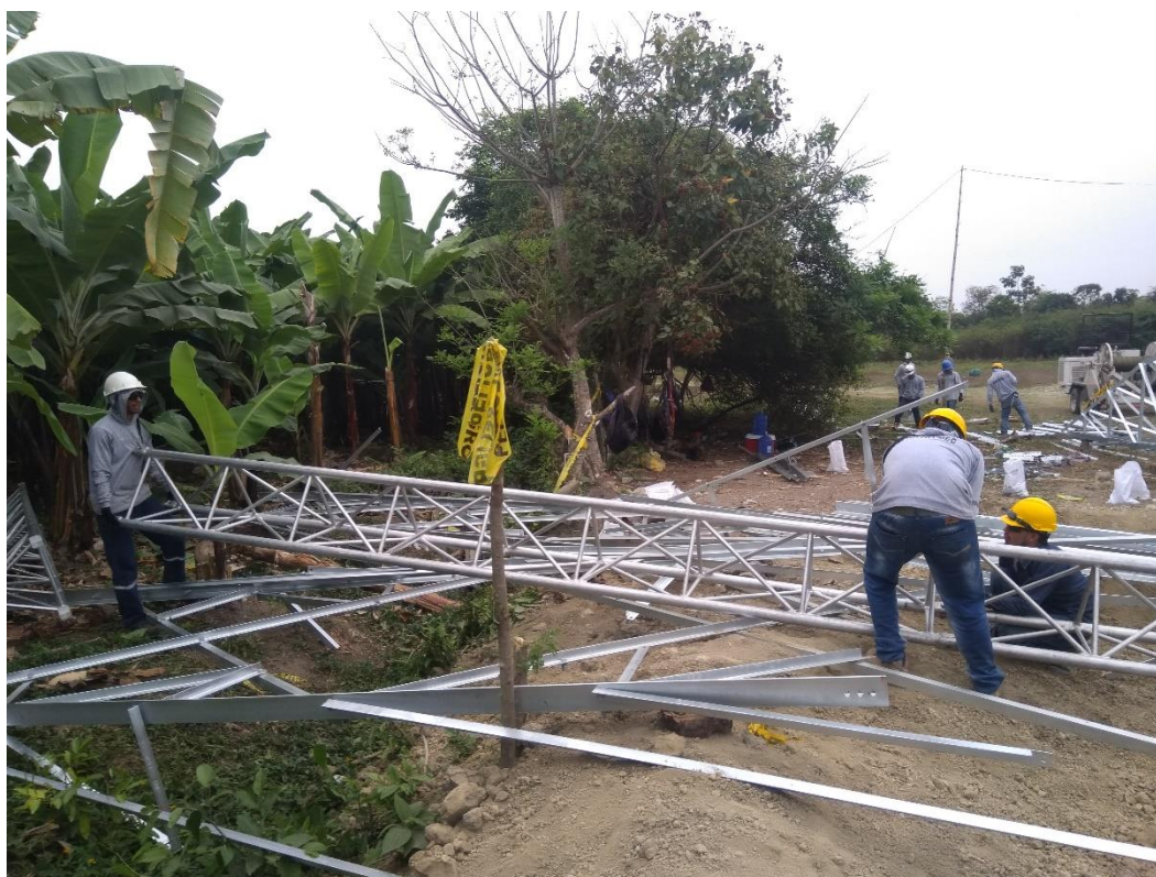
Figura 6. Pre armado de estructuras línea 230 KV Milagro - Babahoyo
