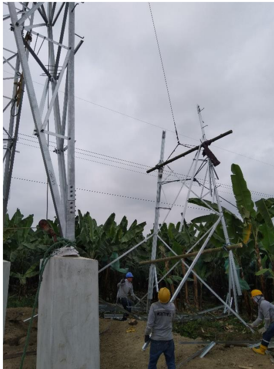
Figura 7. Montaje de estructuras línea 230 KV Milagro - Babahoyo
