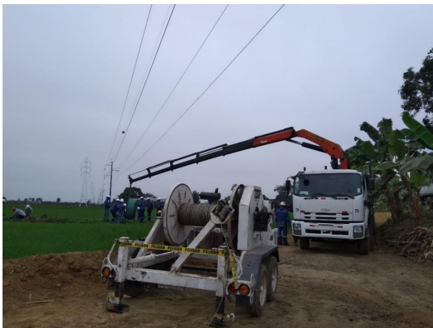
Figura 5. Malacate o puller para el izado de estructuras en la línea 230 Milagro – Babahoyo
