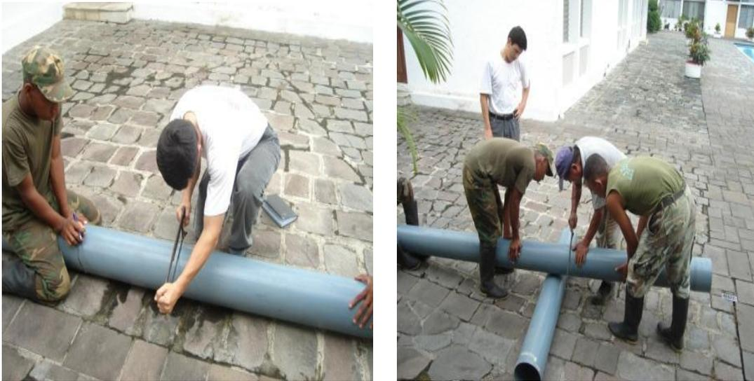
**Fotografía 4.27 Corte de los tubos de PVC de carga y descarga**
