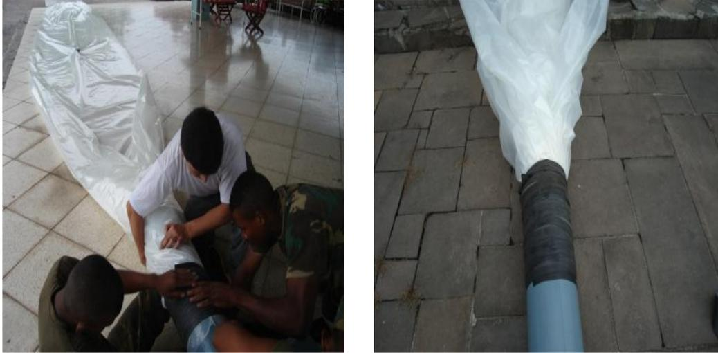
**Fotografía 4.29 Acople de la funda de polietileno al tubo y fijación completa del tubo con el plástico de polietileno**
