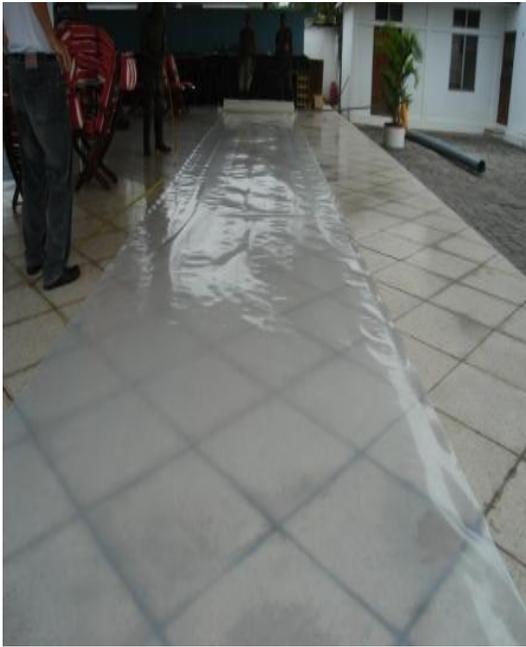
**Fotografía 4.18 Medición de la longitud a cortar del rollo de polietileno.**
