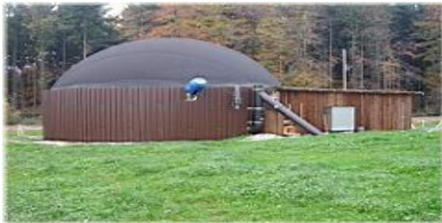
**Figura 3.11 Digestor con tanque de almacenamiento tradicional y cúpula de polietileno.**
