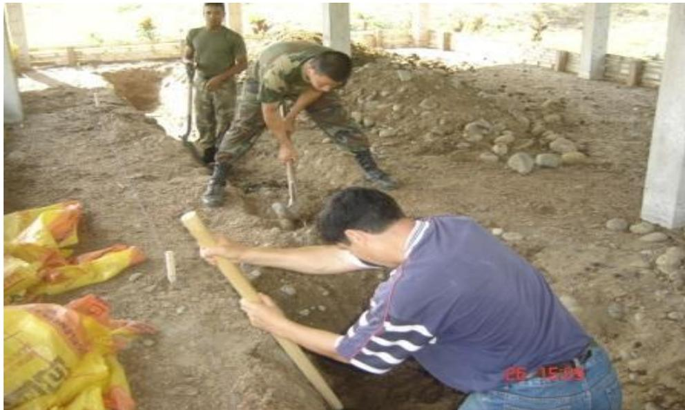
**Fotografía 4.6 Excavación del dique de asentamiento.**
