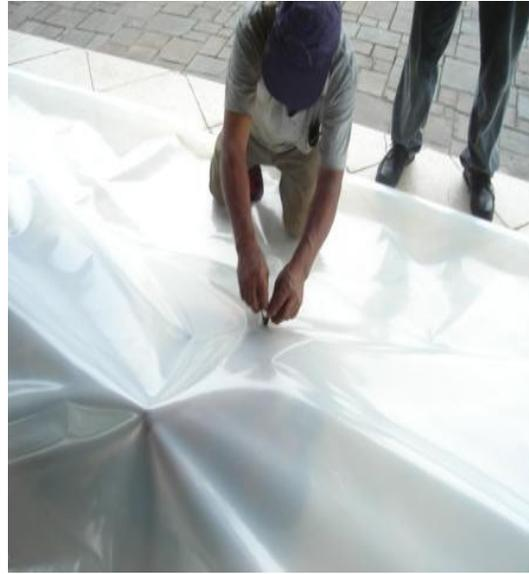
**Fotografía 4.23 Marcación del sitio de corte de la salida de gas**
