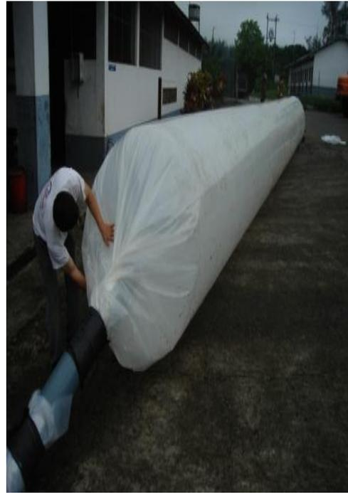
**Fotografía 4.30 Entrada del aire por la línea de la salida del gas e inflado de la funda de polietileno**
