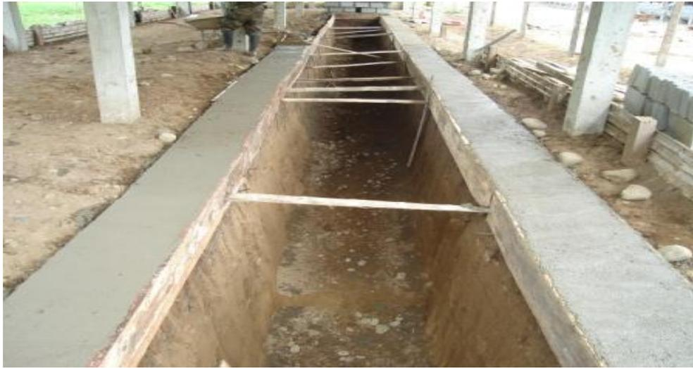
**Fotografía 4.10 Construcción de los pisos laterales del dique de asentamiento.**
