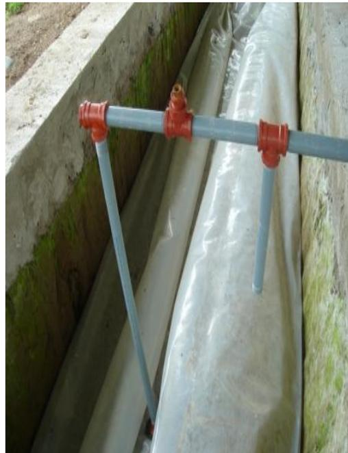
**Fotografía 4.36** Instalación de la tubería completa en el biodigestor
