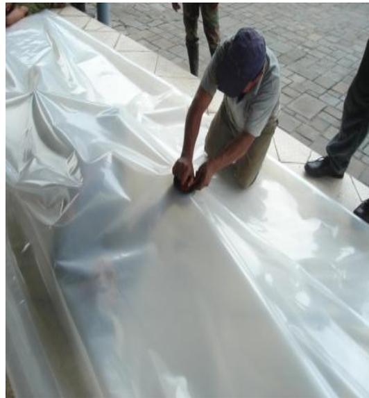
**Fotografía 4.25 Ajuste de la salida de gas**
