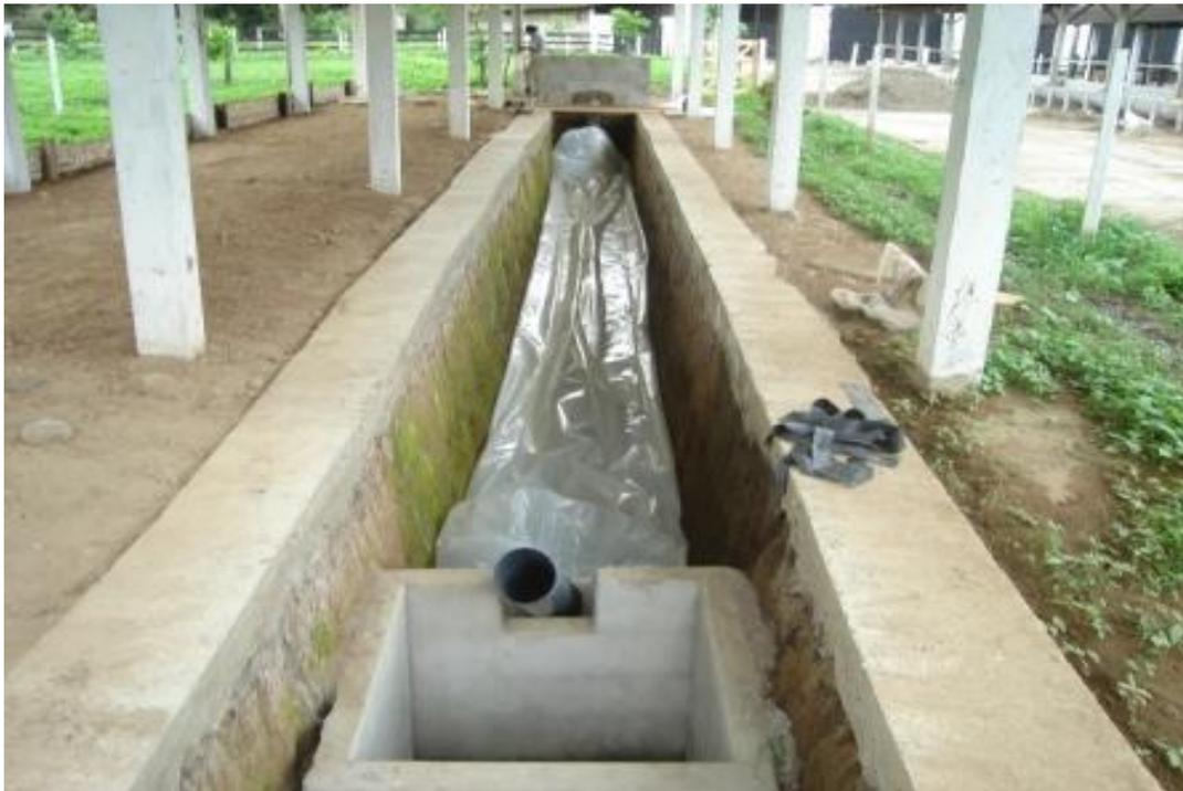
**Fotografía 4.34 Funda de polietileno desinflada una vez colocada en la posición exacta.**
