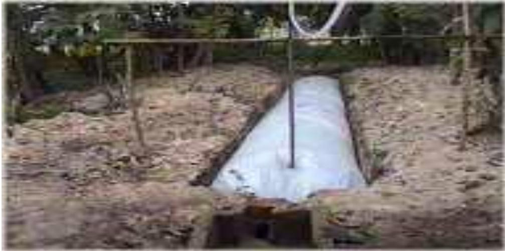
**Figura 3.10 Biodigestor de polietileno tubular**
