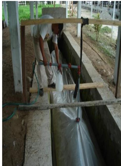
**Fotografía 4.39 Colocación de válvula de seguridad en la línea de salida de biogás**
