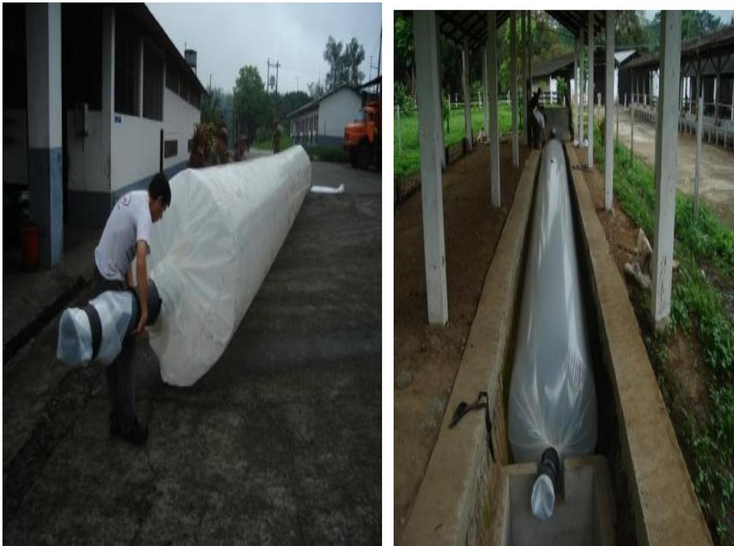
**Fotografía 4.32** Traslado de la funda de polietileno inflada al dique de asentamiento y colocación de la misma en la forma correcta.
