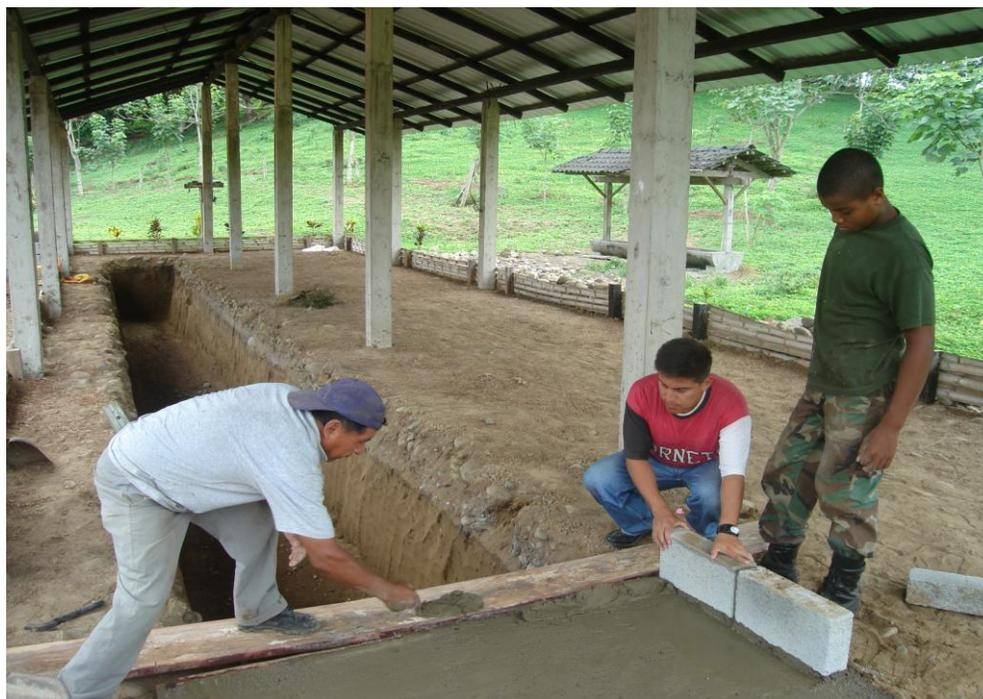
**Fotografía 4.7 Construcción del tanque de carga.**
