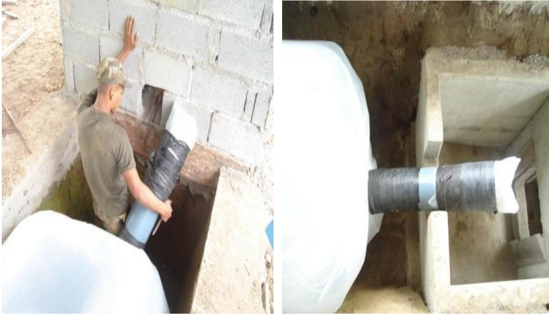
**Fotografía 4.33 Empotramiento del tubo de entrada y salida a las cajas respectivas.**
