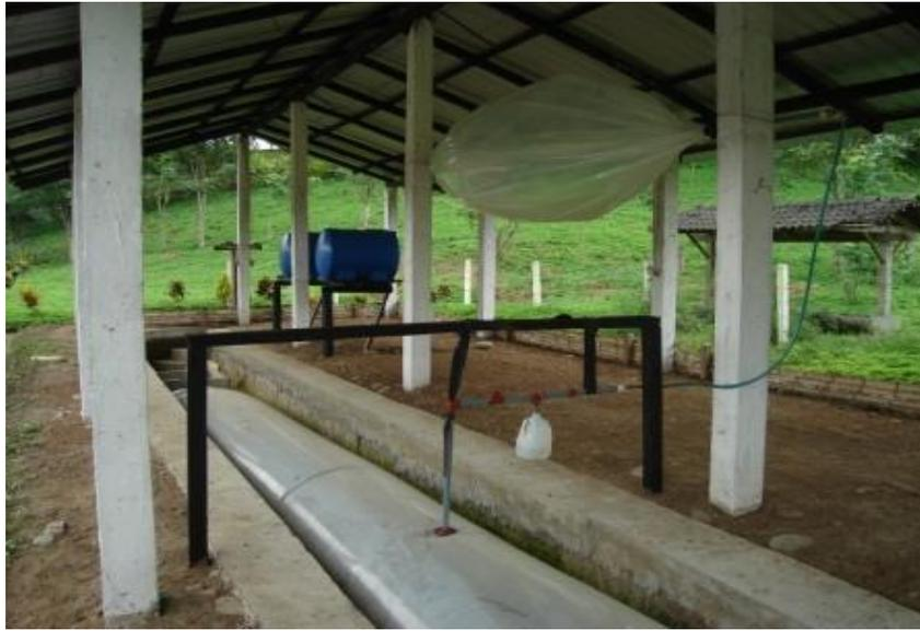
**FOTOGRAFÍA 5.1 Biodigestor completo**
