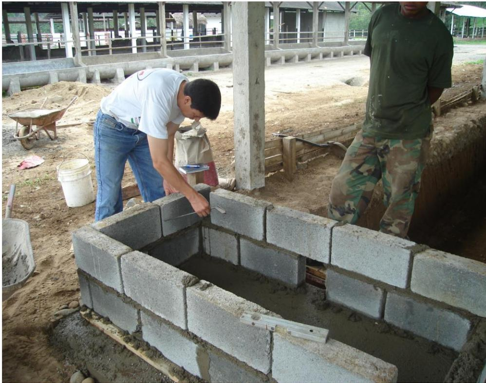
**Fotografía 4.8 Comprobación de medidas para el tanque de carga.**
