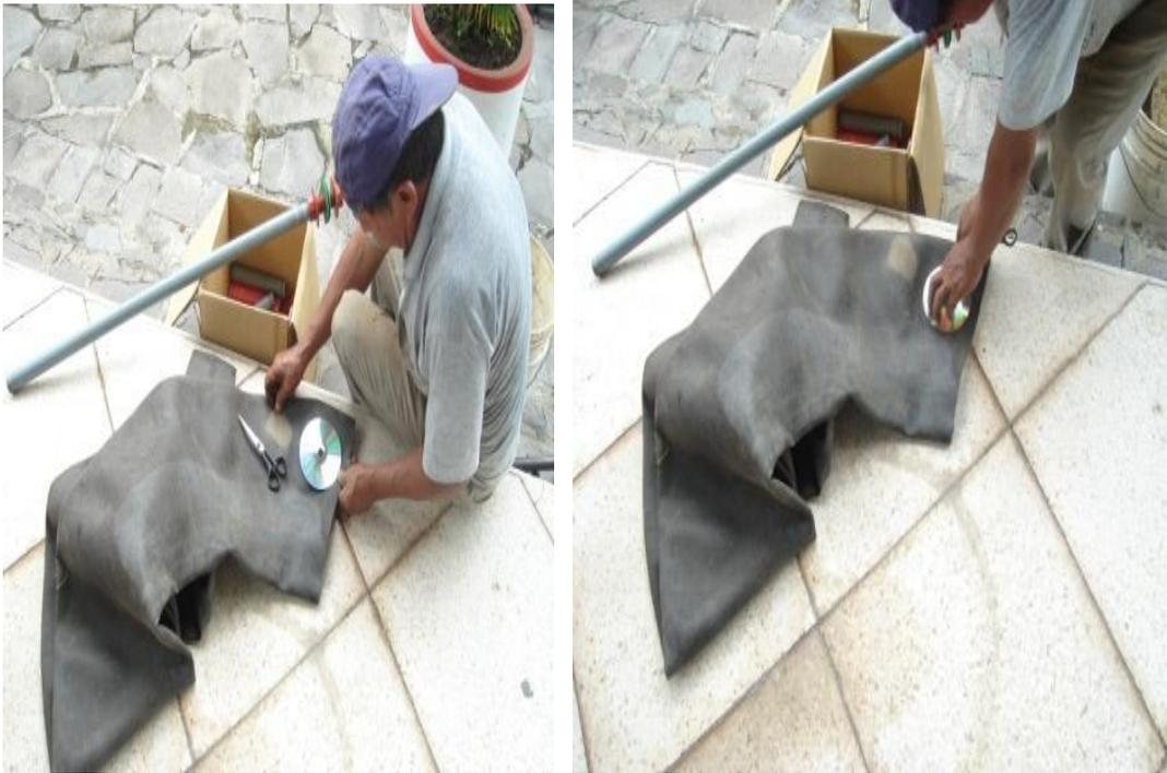
**Fotografía 4.26 Corte de los empaques circulares de caucho para la salida de gas.**
