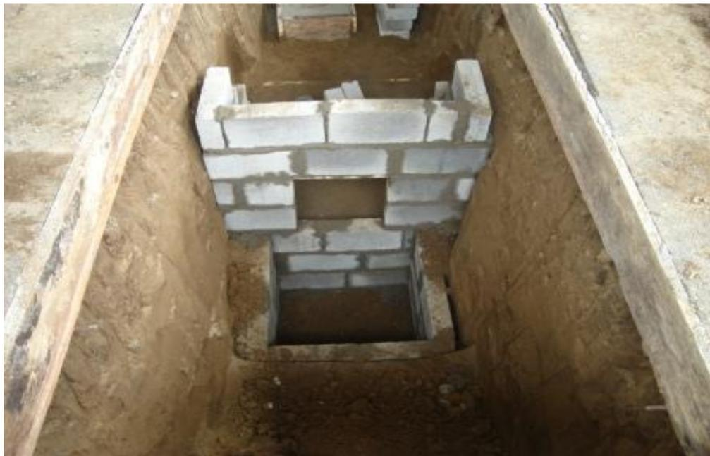
**Fotografía 4.9 Construcción del tanque de descarga y recolección del biol.**
