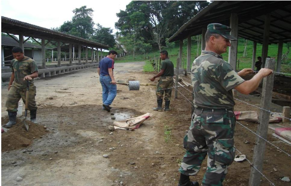
**Fotografía 4.12 Colocación de estacas y alambre de púas.**
