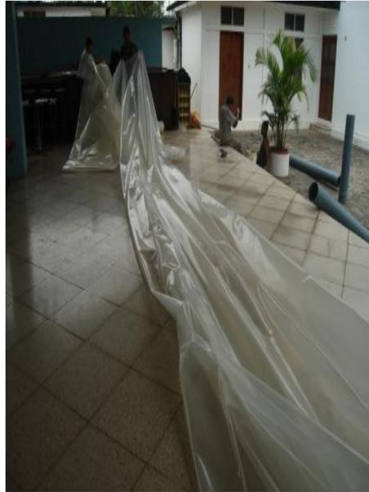
**Fotografía 4.21 Doble funda que incrementa la resistencia**
