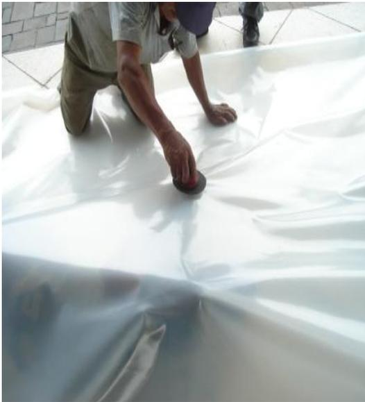
**Fotografía 4.24 Colocación de accesorios para la salida de gas.**
