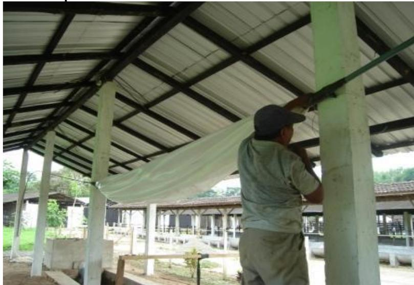
**Fotografía 4.43 Suspensión de la bolsa de almacenamiento de biogás.**
