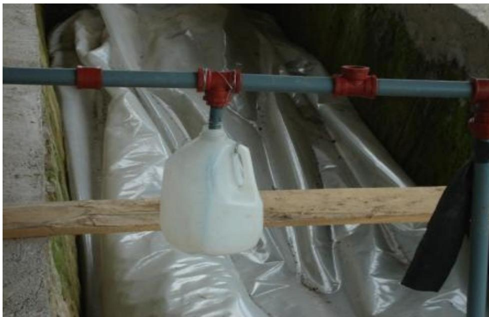
**Fotografía 4.40 Acople de la botella en la tubería de la línea de salida del biogás.**
