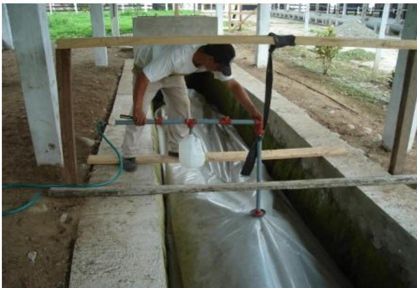
**Fotografía 4.37 Soporte de madera para sujetar la línea de salida del biogás.**
