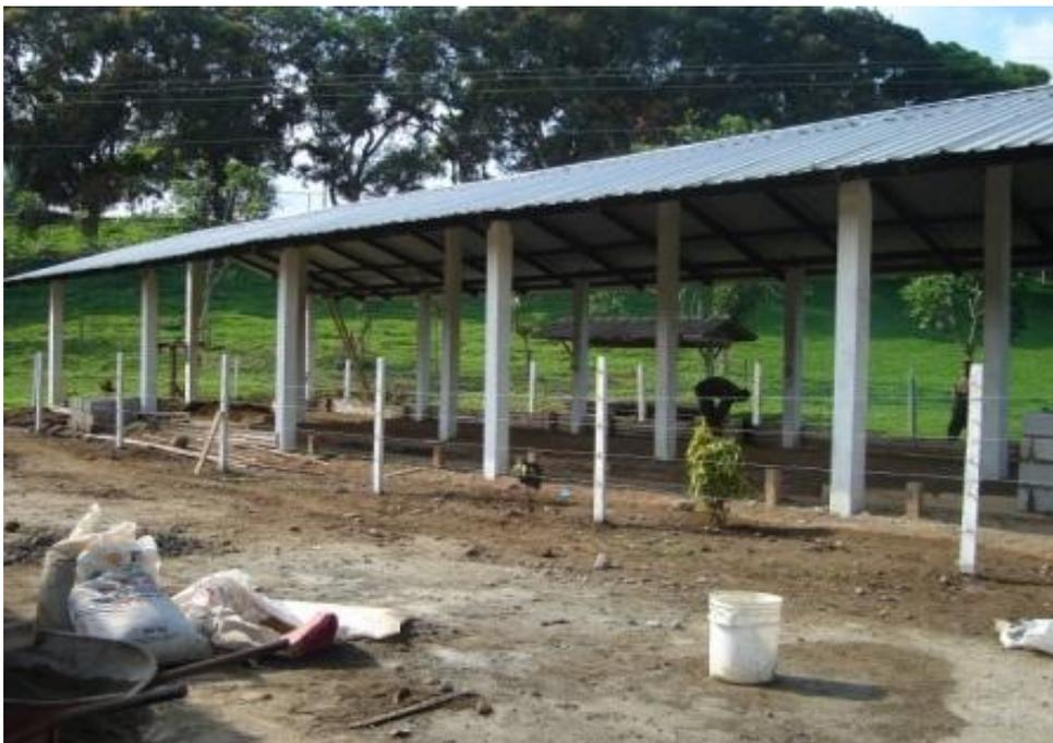
**Fotografía 4.13 Pintado de la cerca y columnas de la estructura de protección.**
