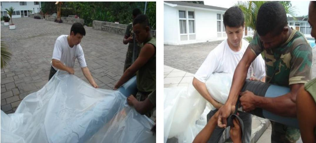
**Fotografía 4.28 Acople de la funda de polietileno al tubo y amarre de las cintas de caucho**
