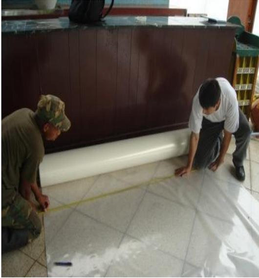
**Fotografía 4.22 Medición del punto donde será ubicada la salida de gas**
