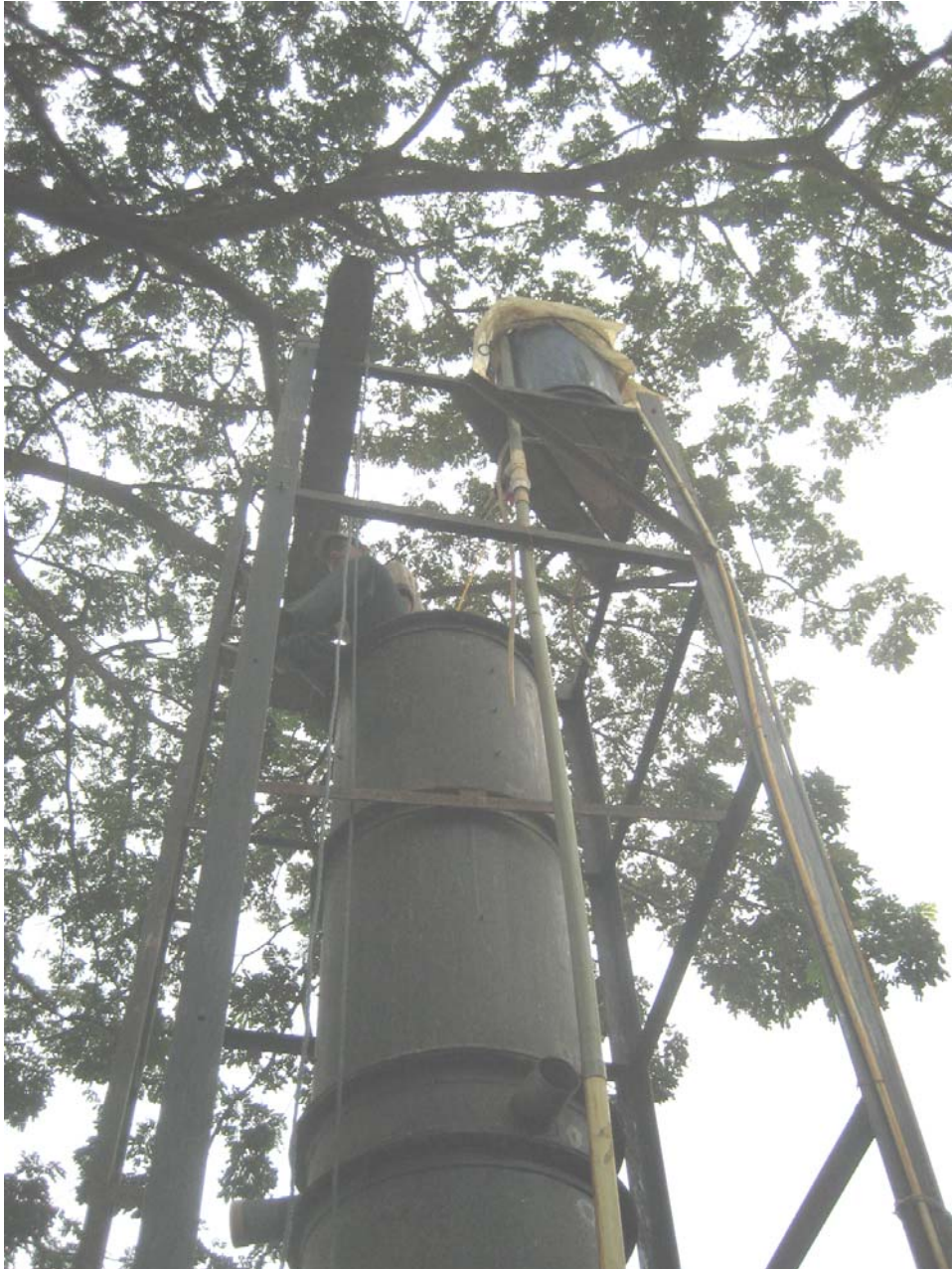
Vista de la parte superior de la torre de biolixiviación de la Empresa Minera Orenas S.A.
