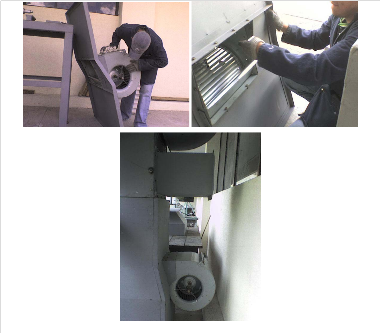
Figura 4.10 Ensamble ventilador 2
