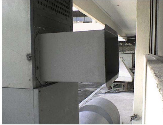
Figura 4.5 Ensamble ducto de salida de aire
