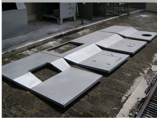
Figura 3.5 Tapas de aislamiento térmico
