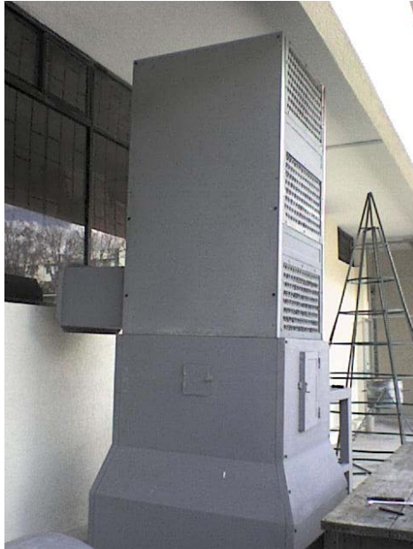
Figura 4.7 Montaje tapas de aislamiento térmico
