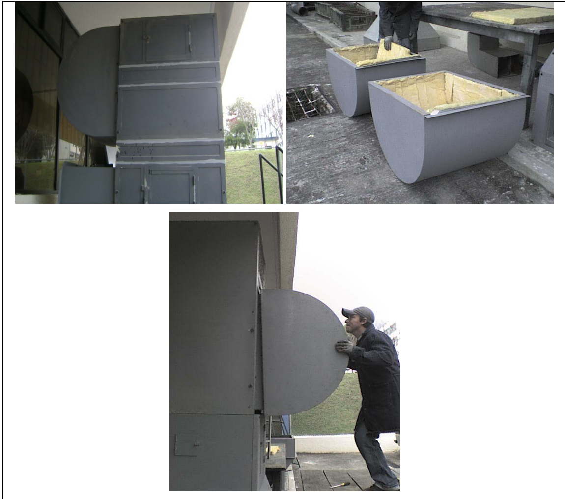
Figura 4.8 Ensamble de ductos de aire
