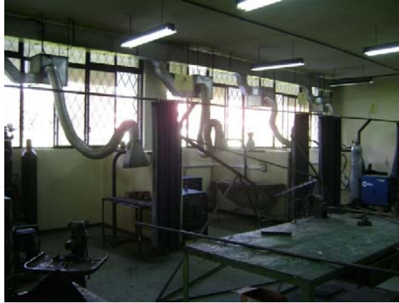
Figura 4.18 Área de soldadura
