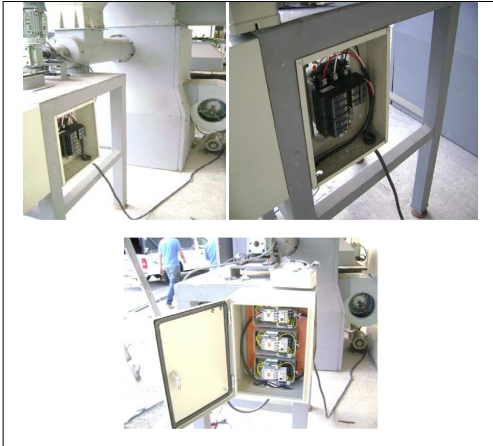
Figura 4.13 Instalación caja de control
