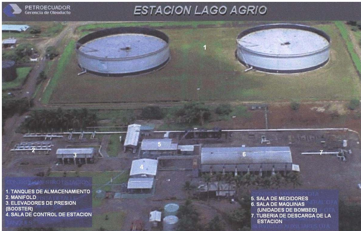
Figura 2.3. Estación de bombeo Lago Agrio
