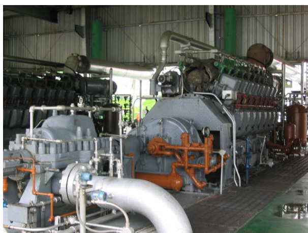
Figura F9. Unidad de bombeo
