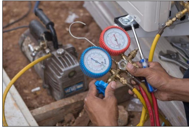
Figura 108. Prueba de vacío en el sistema de A/C.
