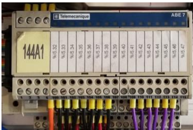
Módulo E/S Telemecanique ABE7-HR1631
