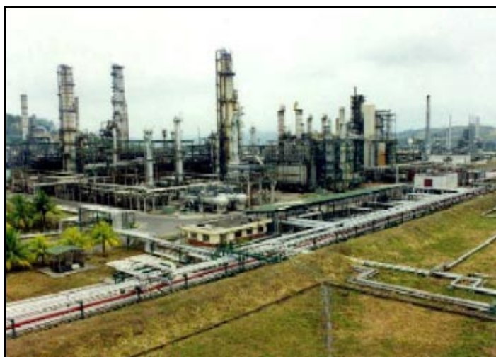
Figura. 1.1. Vista panorámica de Refinería Estatal Esmeraldas
