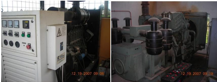
**Figura 3.3 Generadores de 60 y 360 Kva**
