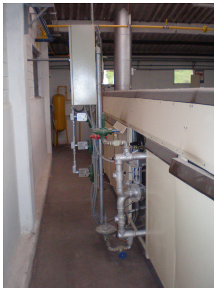
Figura. 2.6. Sistema de Ignición a gas
