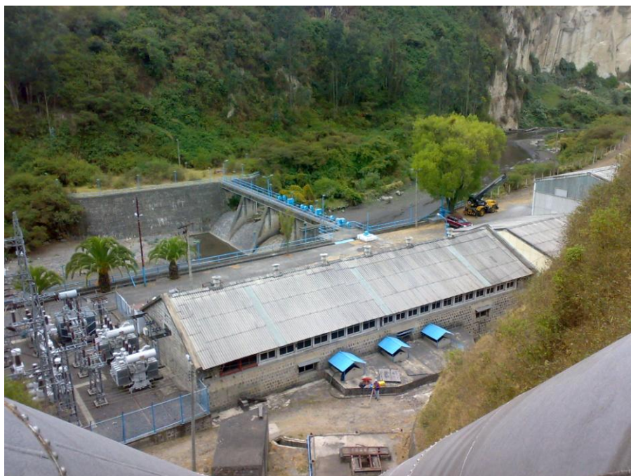
Figura 4. 1 Casa de Máquinas Antigua Guangopolo
