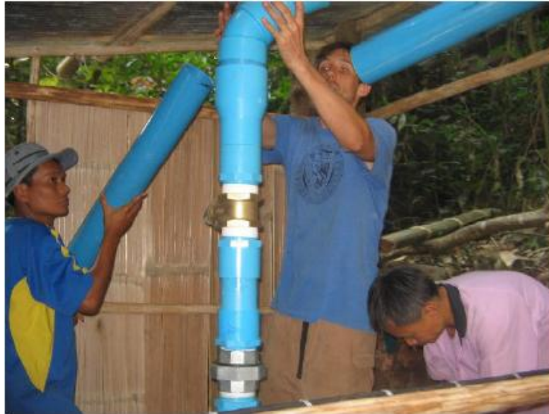
Figura 1.3 Instalaciones Internas en Campo
