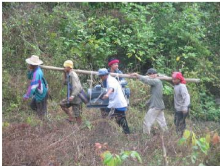
Figura 1. 2 Transporte de la Bomba Centrífuga en Campo Fuente: Chris Greacen, Reporte de Proyecto Micro central Huai Kra Thing
