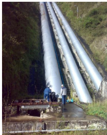
Figura 4. 3 Plataforma de Proyecto y Tubería de Presión
