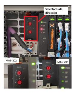
Direcciones de los módulos DeviceNet de las estaciones 202, 205 y PLC maestro configuradas en RSNetworx
