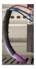
Existen tres tipos de cables Devicenet: Plano, delgado, grueso. Según la cantidad de corriente y velocidad se diferenciará cada tipo.
