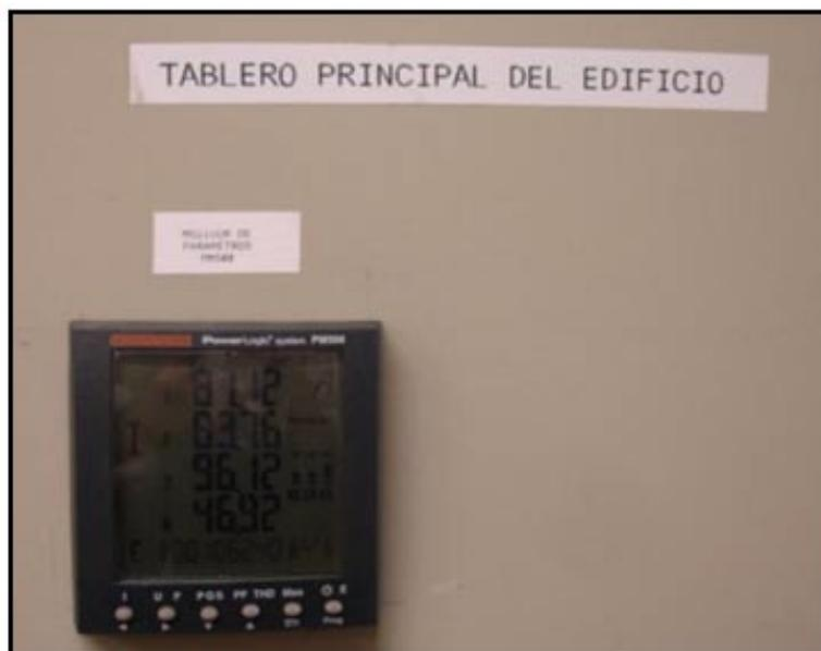
Figura. 5.17. Central PM500 en el TDP del edificio.
