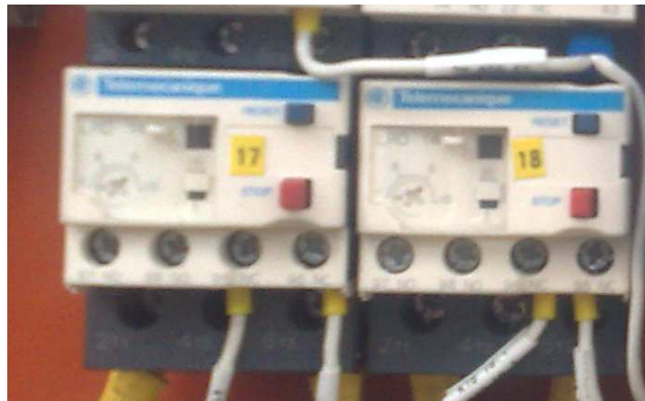
Figura 5.8. Relé Tripolar Térmico.
