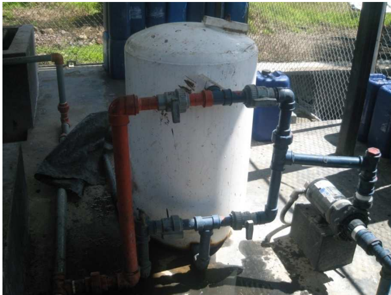
Figura 2.4. Tanque de filtraje
