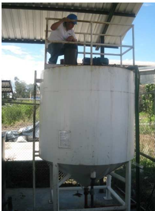
Figura 2.2. Tanque de sedimentación.
