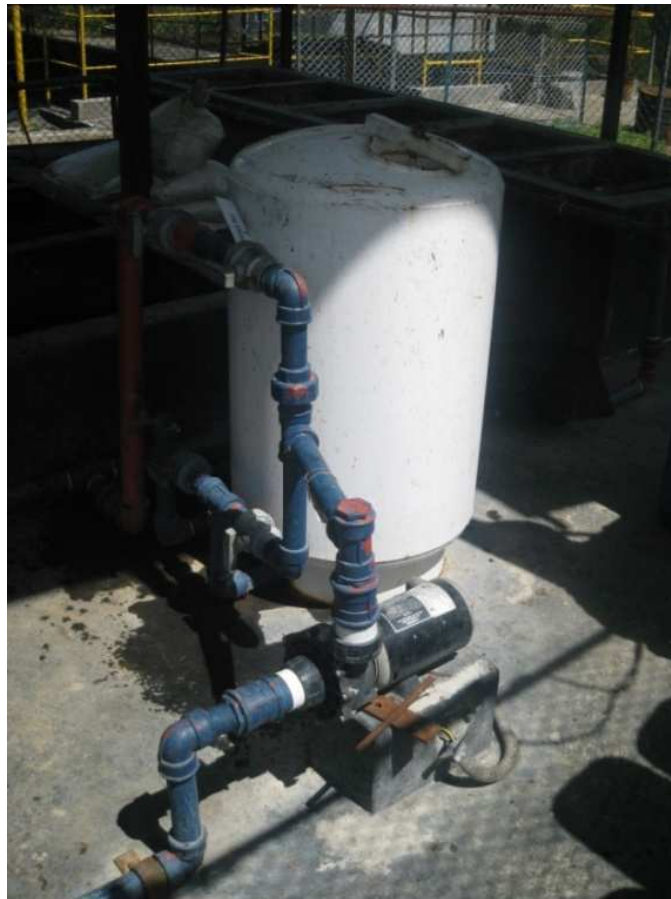
Figura 3.6. Tanque de Filtraje
