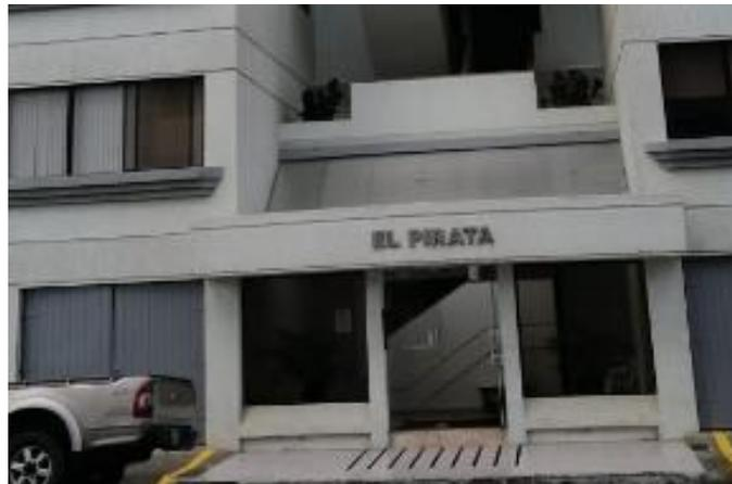
Debido a la orientación del edificio el lado más largo se encuentra direccionado hacia el Océano Pacífico, por lo cual este lado será el que reciba directamente el impacto del tsunami. No cuenta con escaleras de emergencia exteriores que permitan una evacuación vertical óptima.
