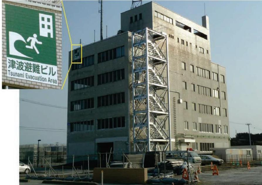
*Nota:* Edificio de cinco pisos en Kesenuma, Japón, con una escalera exterior de metal instalada para proporcionar acceso sin obstáculos al área de refugio en el techo, tomado de (Fraser et al., 2012)
