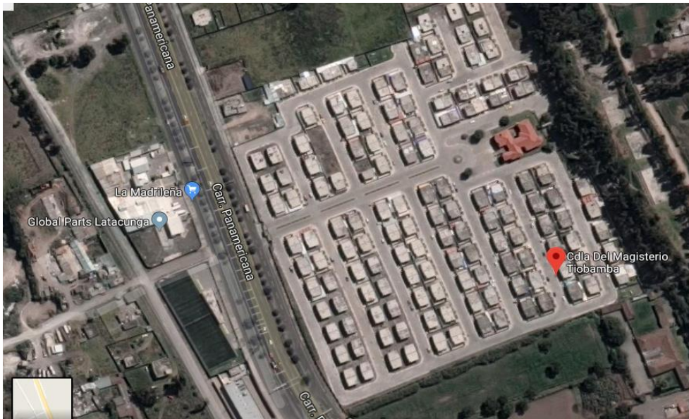
Figura 15: Ubicación Conjunto Habitacional Tiobamba.
