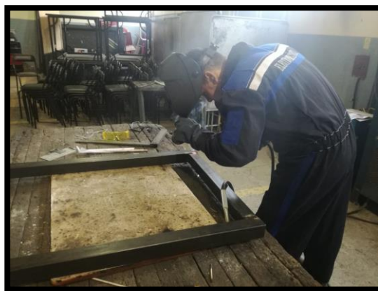
Figura 24. Proceso de calibración y soldadura.
