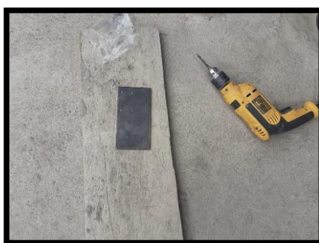
Figura 37. Perforación de la placa.
